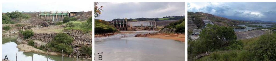
Figura 4 – Barragens das usinas hidrelétricas de Itutinga (A), Funil (B) e Furnas (C).
