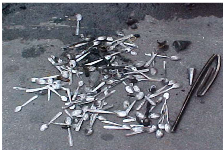
Figura 38 - Objetos sólidos retirados de rede coletora de esgoto
