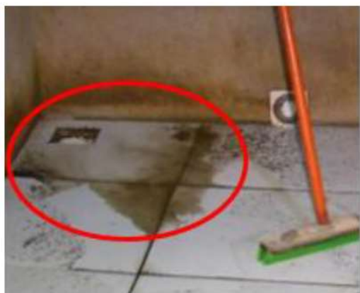
Figura 46 - Exemplo de retorno de material pelo sistema de esgoto
