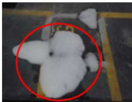
Figura 46 - Exemplo de retorno de material pelo sistema de esgoto
