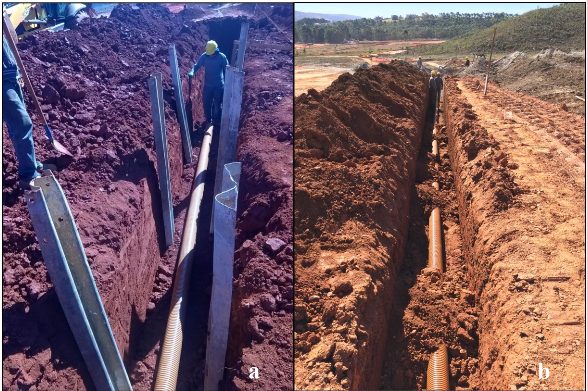
Figura 11 - Fotografias da rede coletora de esgoto sendo assentada.
