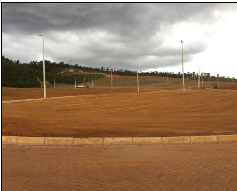
Figura 12 – Canteiro central do empreendimento A conformado.
