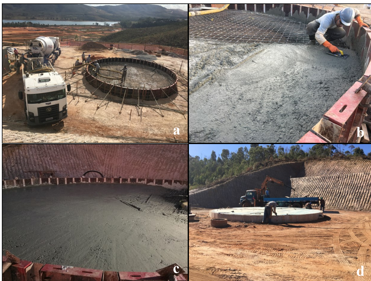
Figura 10 - Fotografias da base do reservatório apoiado.
