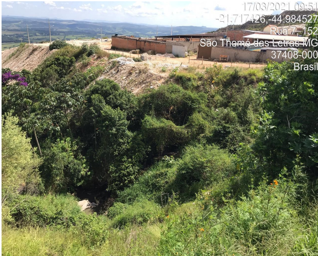
Figura 11 - Registro fotográfico do ponto de lançamento de esgoto da Sede Municipal-cachoeira da Covoca ou Cachoeira
