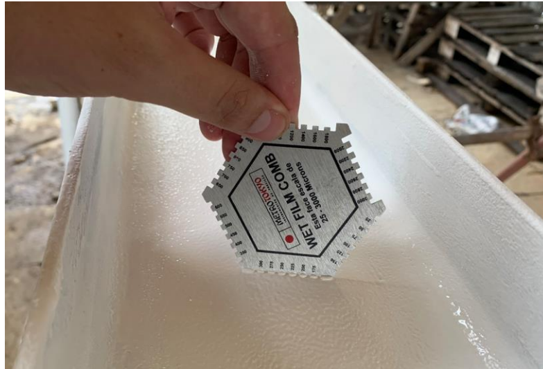
Figura 4-3- Aferição da espessura de tinta aplicada.
