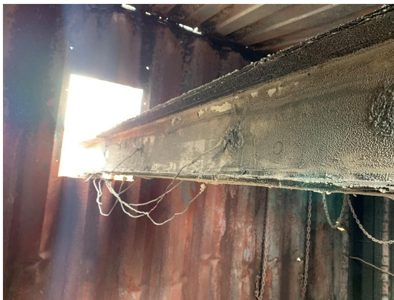
Figura 5-28 - Deformada da viga V3-W200X31.3 após ensaio
