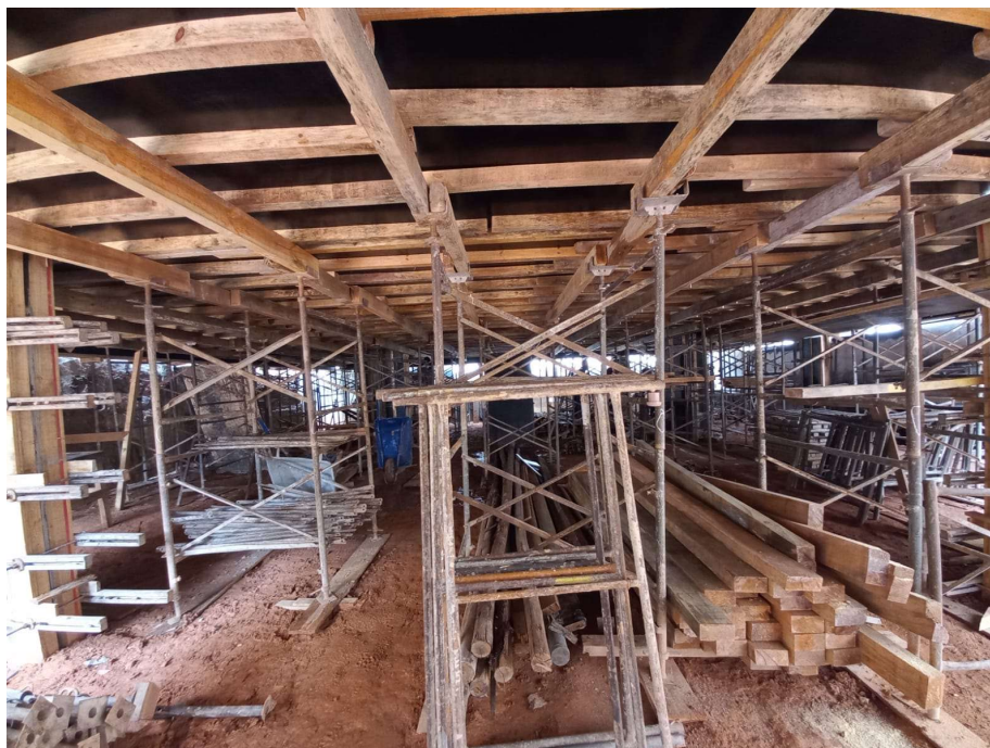
Figura 10 - Execução das fôrmas da 1ª laje. Fonte: Acervo do autor
