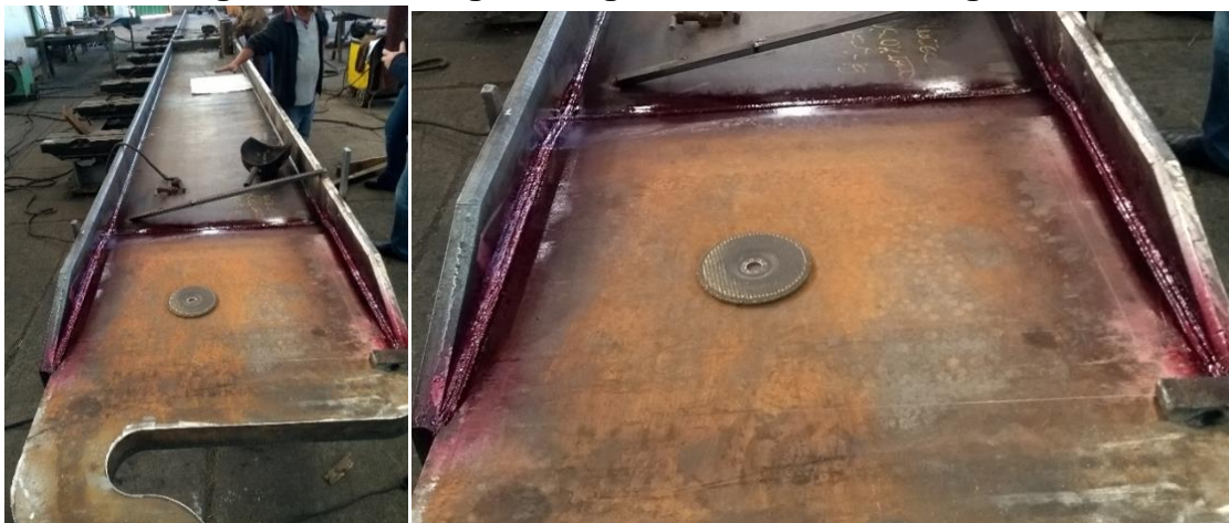
Figura 26: Montagem do gancho na alma da Viga
