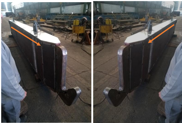
Figura 27: Estrutura montada e posicionada na posição para processo de solda
