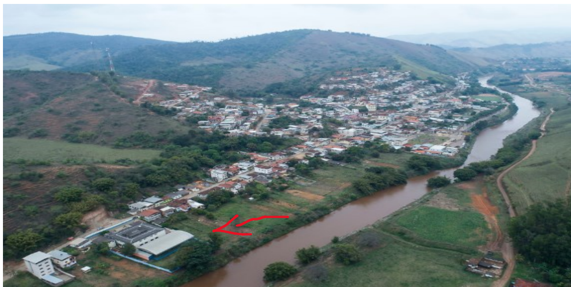
Figura 10: Sede do município de Barra Longa com a EEPJEG às margens do Rio Carmo
