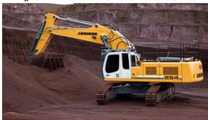
Figura 6 - Retroescavadeira Hidráulica sobre esteiras.
