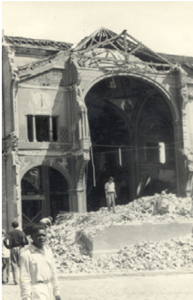
Figura 3 - Demolição da Igreja do Rosário, 1956. Fonte: Coleção V8, CMU.
