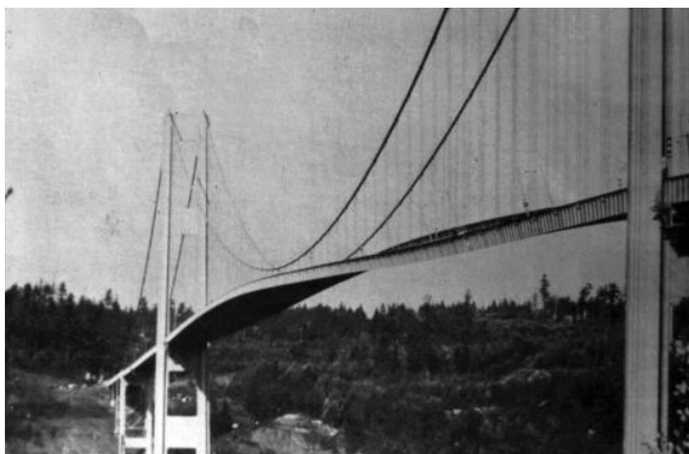
Figura 12 – Ponte de Tacoma Narrows nos Estados Unidos durante a vibração provocada pelo flutter .
