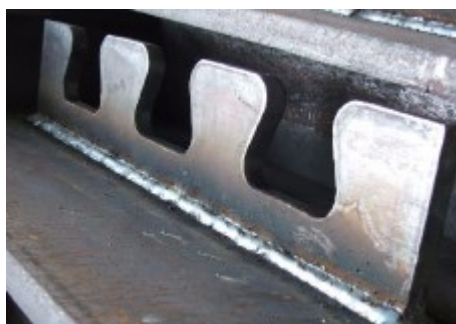
Figura 2.13 – Conector Crestbond. Fonte: Veríssimo, 2007.
