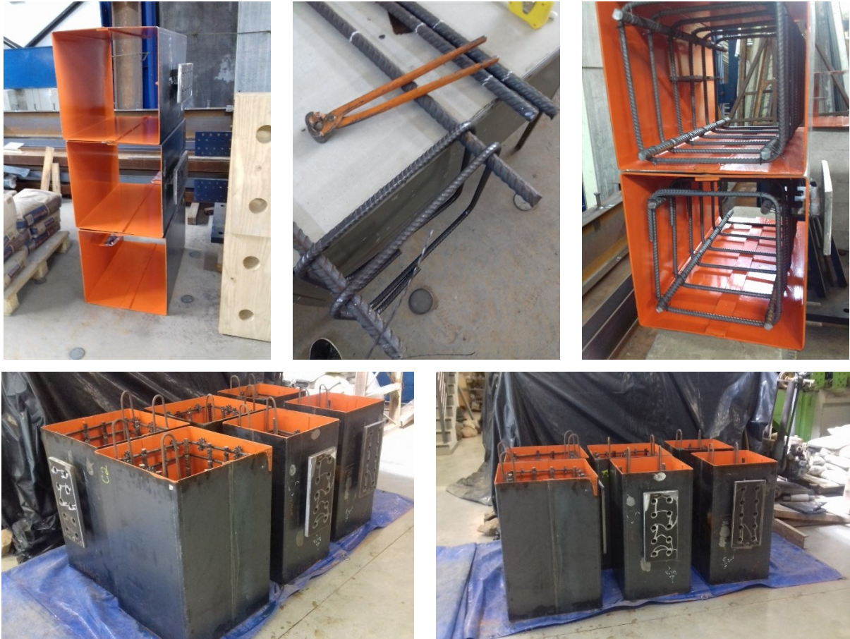
Figura 3.2 – Etapas de preparo para concretagem dos modelos. Fonte: Autoria própria.
