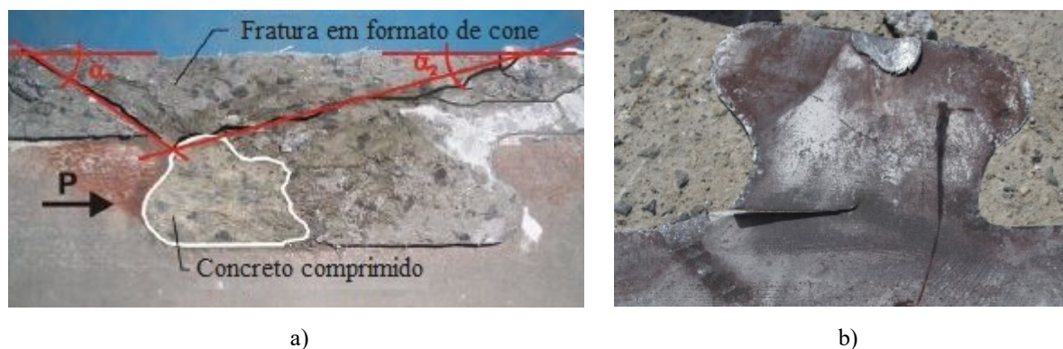
Figura 2.15 – Falha por a) pry-out do concreto e b) falha do aço do conector Fontes: a) Heinemeyer, 2011; b) Lorenc et al. , 2014.
