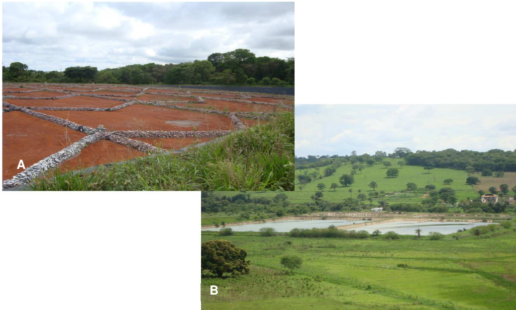
Figura 4: (A) Aterro controlado de Matozinhos que nunca foi utilizado e (B) Lagoas de estabilização da Estação de Tratamento de Esgoto do município de Matozinhos.
