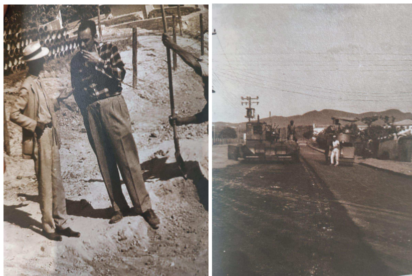
Figura 4 - Obras nos bairros Sagrada Família e Barreiro
