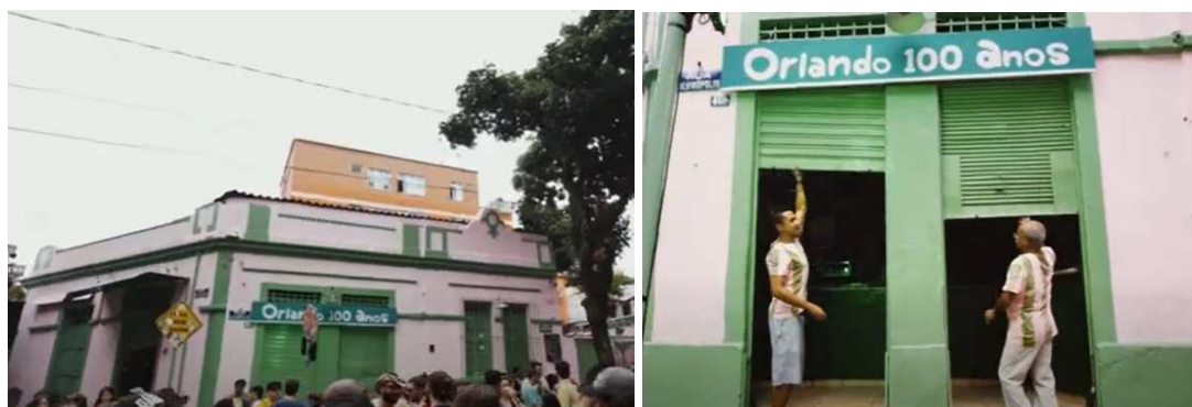
Figura 9 - Fachada do Bar do Orlando
