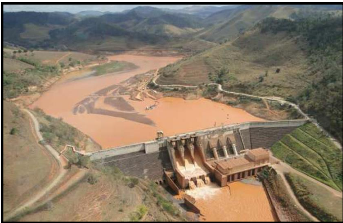
Figura 5.3 - Barragem do reservatório de Candonga. Ao fundo, as operações iniciais de dragagem dos materiais depositados no evento, no setor mais próximo à barragem.
