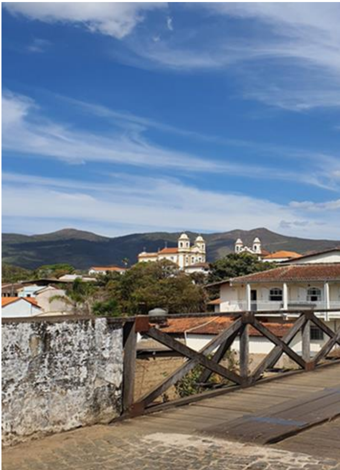
Ponte de Tábuas: São Gonçalo para Munssus
