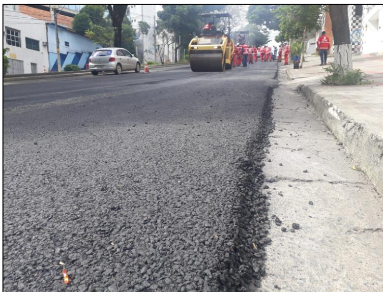
Figura 64: Aplicação de mistura asfáltica tipo SMA – Avenida do Contorno em 2020
