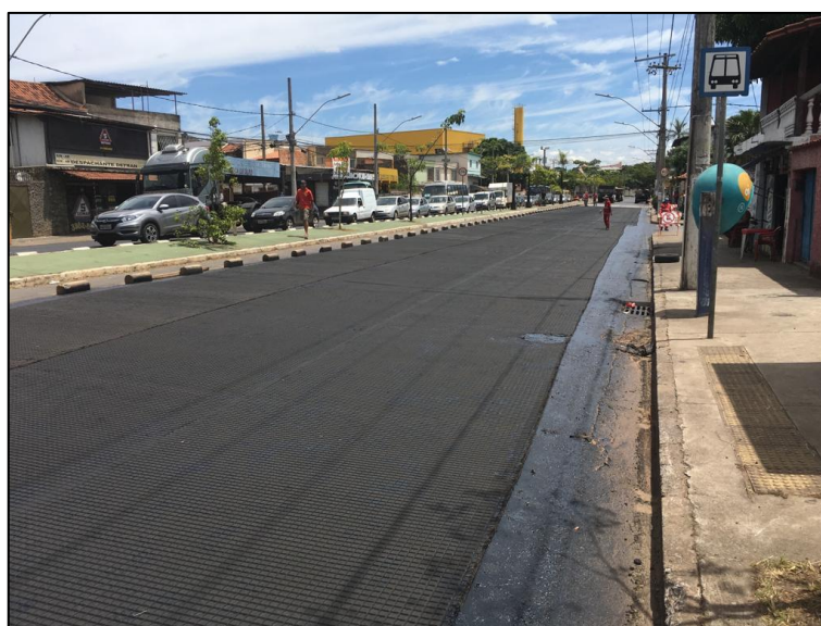
Figura 69: Aplicação de geogrelha como camada inibidora da propagação de trincas
