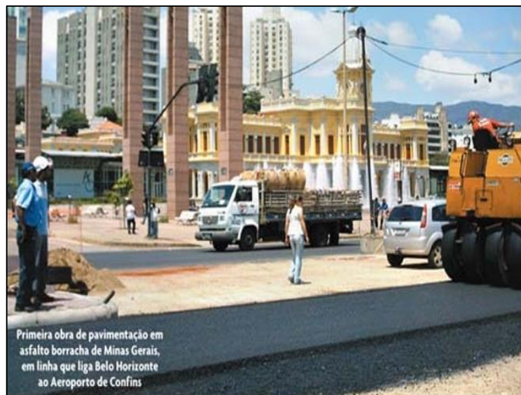
Figura 60: Pavimentação em asfalto borracha - Avenida dos Andradas em 2007
