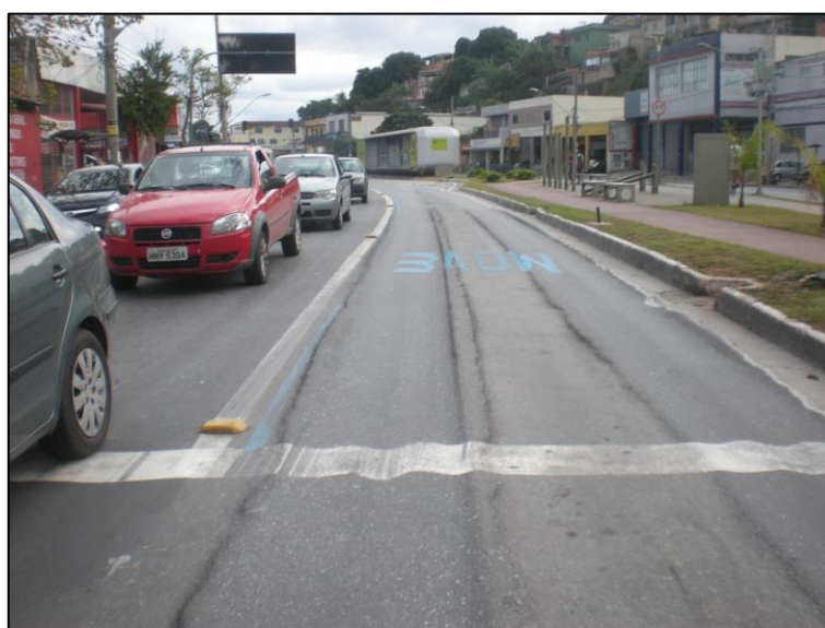
Figura 63: Afundamento nas trilhas de roda
