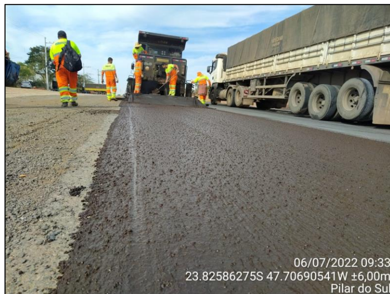
Figura 55: Aplicação de microrevestimento asfáltico a frio
