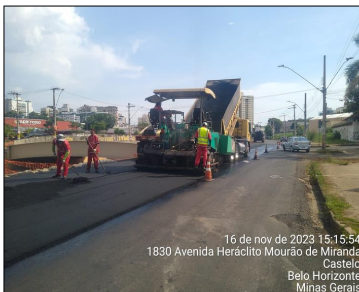
Figura 62: Execução de recapeamento asfáltico com asfalto borracha
