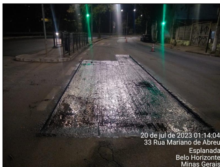
Figura 56: Recuperação funcional de pavimento através de remendo superficial
