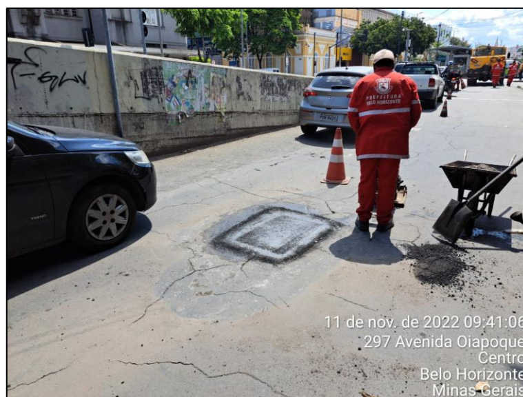
Figura 53: Reparo pontual no pavimento
