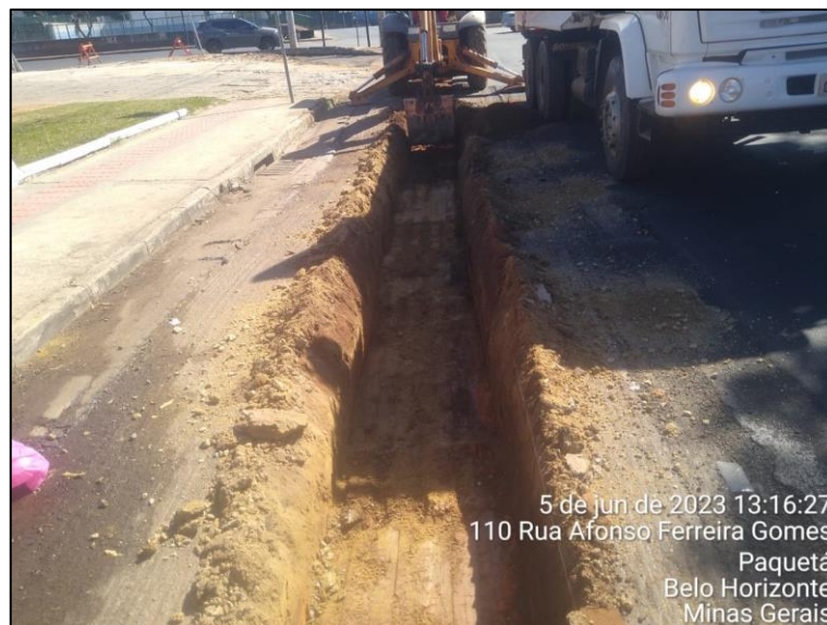
Figura 57: Recuperação estrutural de pavimento através de remendo profundo
