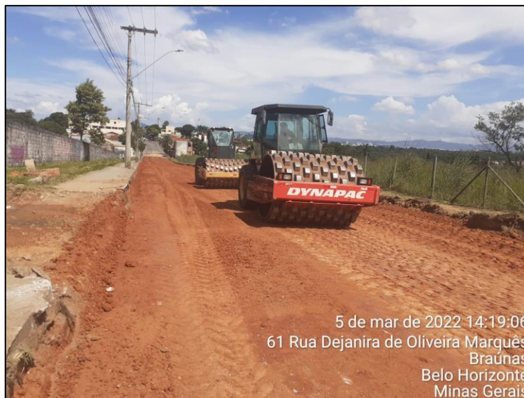
Figura 71: Reconstrução total de pavimento
