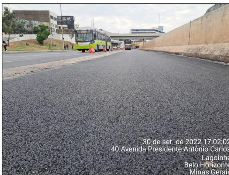
Figura 66: Aplicação de camada de SMA 0/11S
