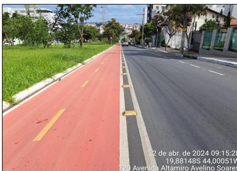
Figura 52: Pavimento íntegro sem necessidade de intervenção
