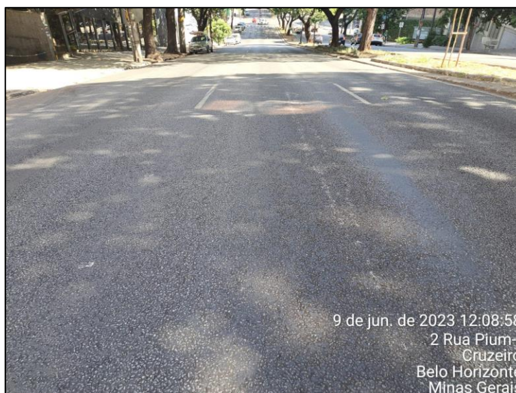
Figura 65: Condição funcional do pavimento da Avenida do Contorno em 2023
