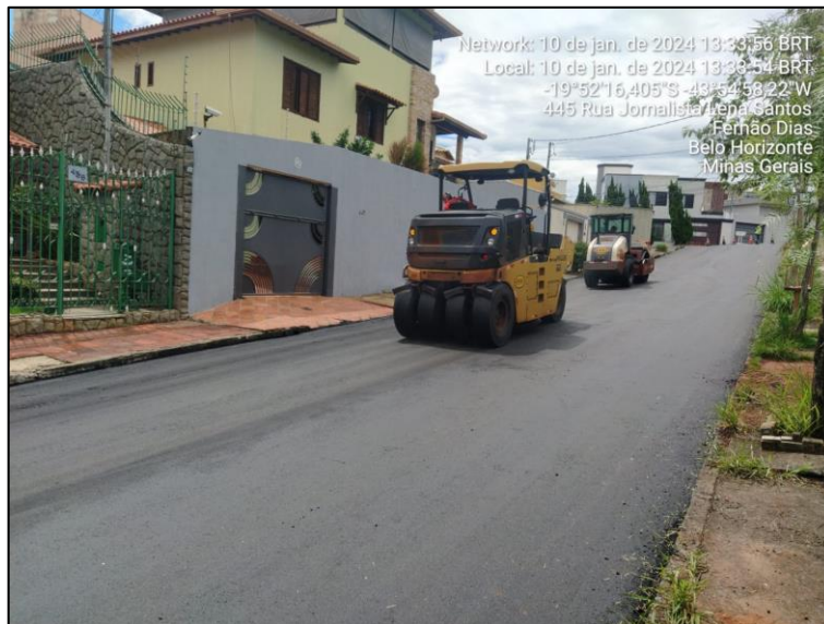
Figura 59: Recapeamento com CBUQ convencional faixa C CAP 50/70
