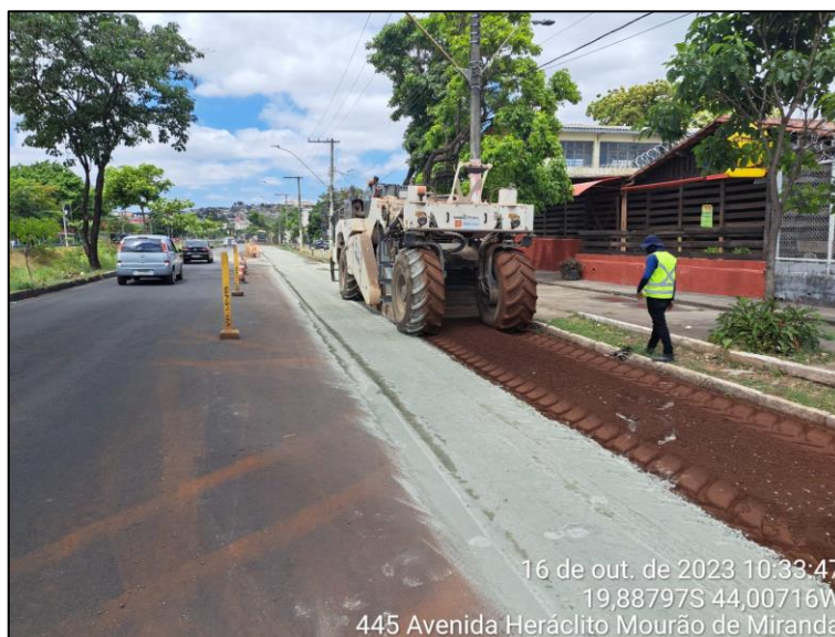
Figura 70: Reciclagem de pavimento com adição de cimento e agregados pétreos
