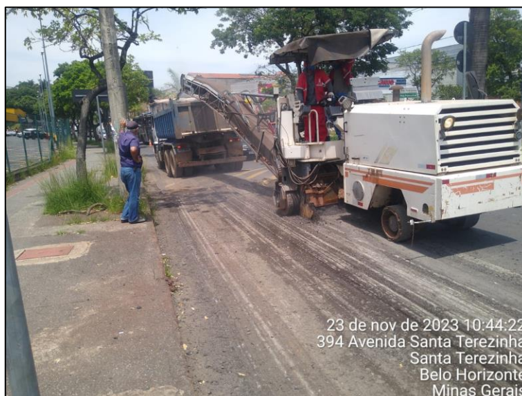
Figura 67: Fresagem a frio de revestimento asfáltico
