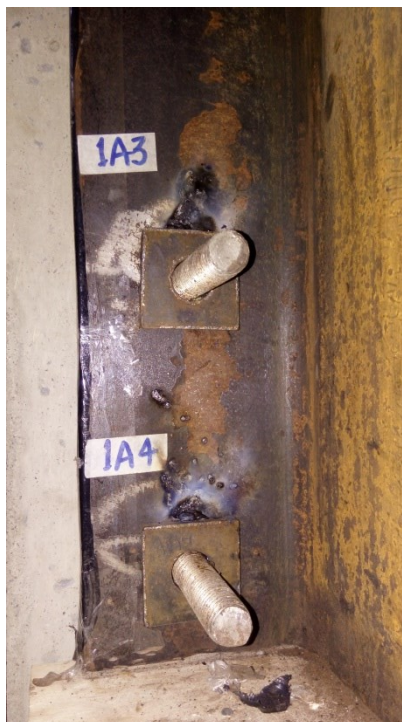
Figura 3.7 – Arruelas posicionadas antes da execução da solda.
