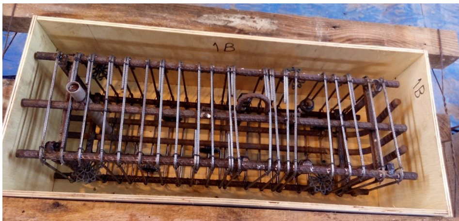
Figura A.10 – Montagem da armadura na forma antes da concretagem do bloco.
