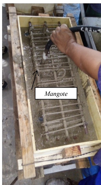
Passo 6: Concretagem com vibração contínua da mistura
