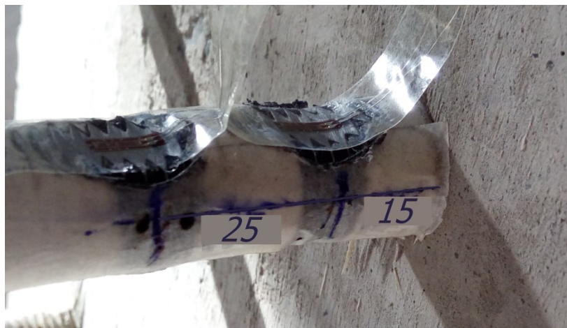
Figura 3.20 – Instalação dos extensômetros no chumbador.
