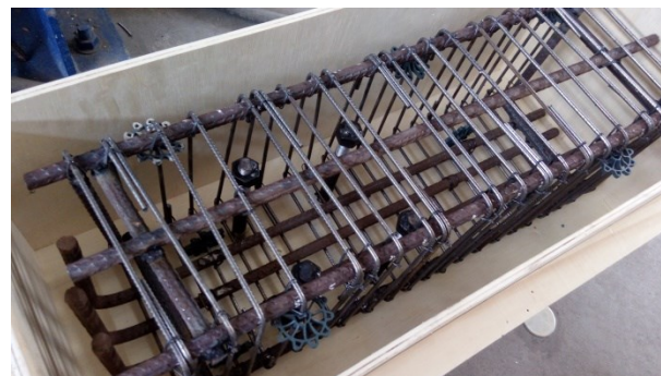
Passo 2: Posicionamento da armadura e dos chumbadores dentro da forma Aplicação de desmoldante nas formas.
