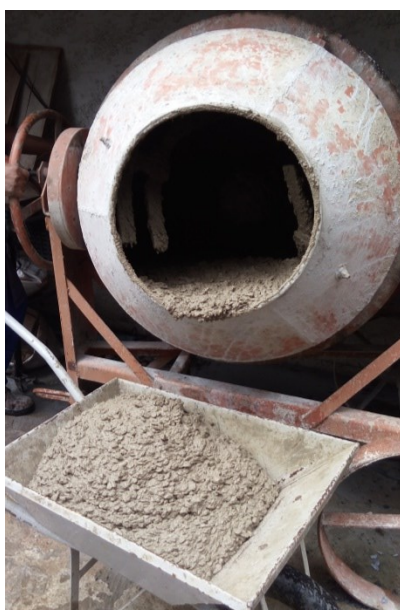
Passo 4: Preparo da mistura do concreto na betoneira
