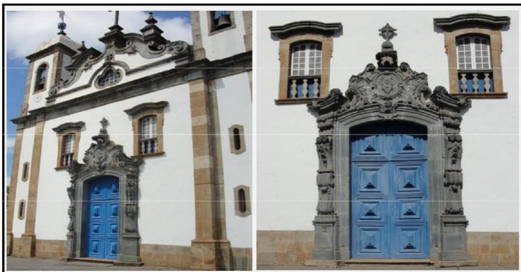
**Figura 1.** - Frontispício do Santuário Bom Jesus do Matosinhos. À esquerda, fachada contendo elementos construídos com a utilização de granito e à direita, destaque para a portada construída com a utilização de esteatito, texturalmente homogêneo e com coloração cinza escura predominante (fotografias - Neves 2016).
