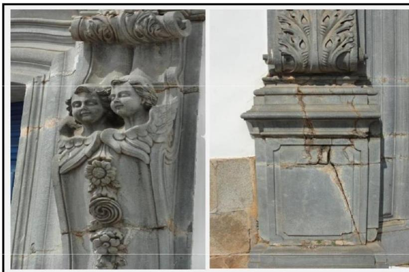
**Figura 2.** Portada com presença de esteatito maciço, mostrando granulação fina e coloração cinza escura. Notar fissuras na base esquerda da portada causadas possivelmente por compressão (fotografias - Neves 2016).
