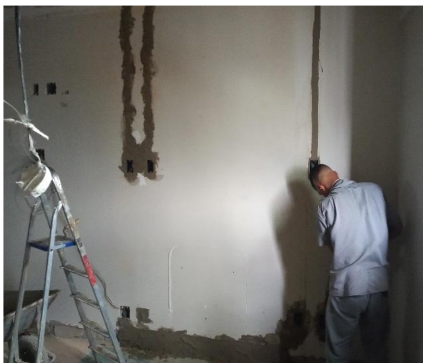
Figura 15 – Instalação das estruturas elétricas.
