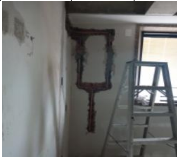
Figura 16 – Instalação das tubulações elétricas.
