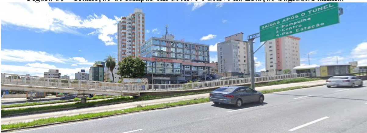
Figura 60 - Transição de rampas em declive e aclive na Estação Sagrada Família.
