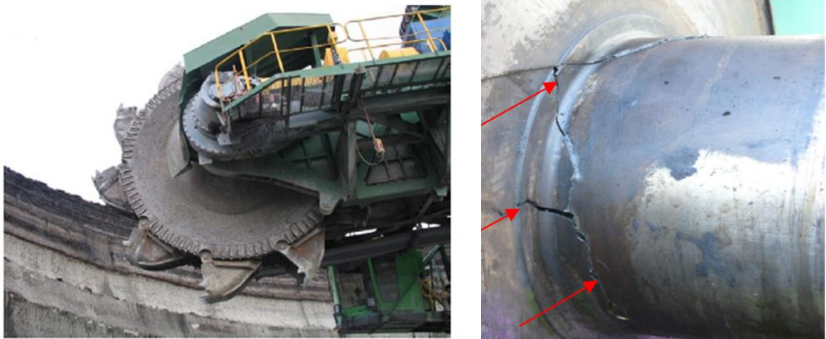
Figura 13 – Foto do sistema da roda de caçambas e eixo com fratura.
