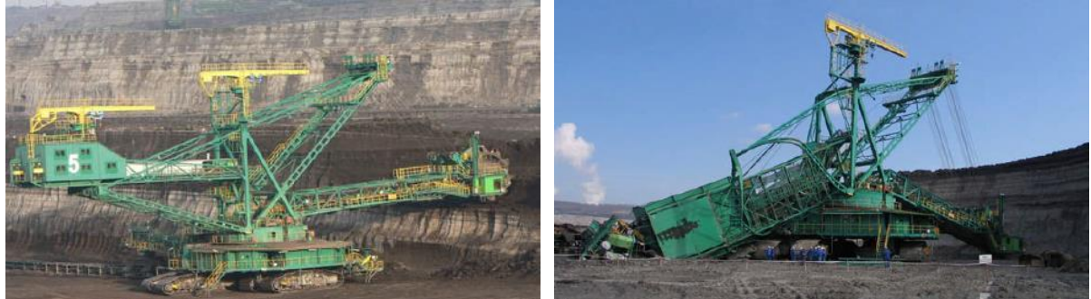
Figura 4 – Fotos da recuperadora antes e após a falha catastrófica.
