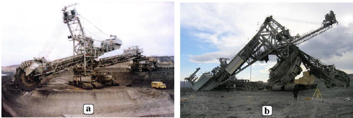
Figura 11 – Foto da máquina antes (a) e após colapso total (b).
