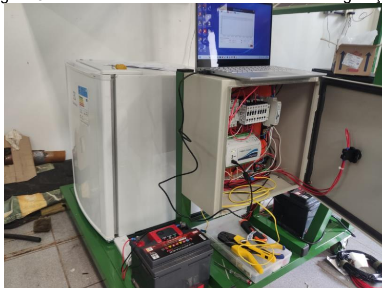
Figura 8 – Vista frontal e lateral da bancada de refrigeração.
