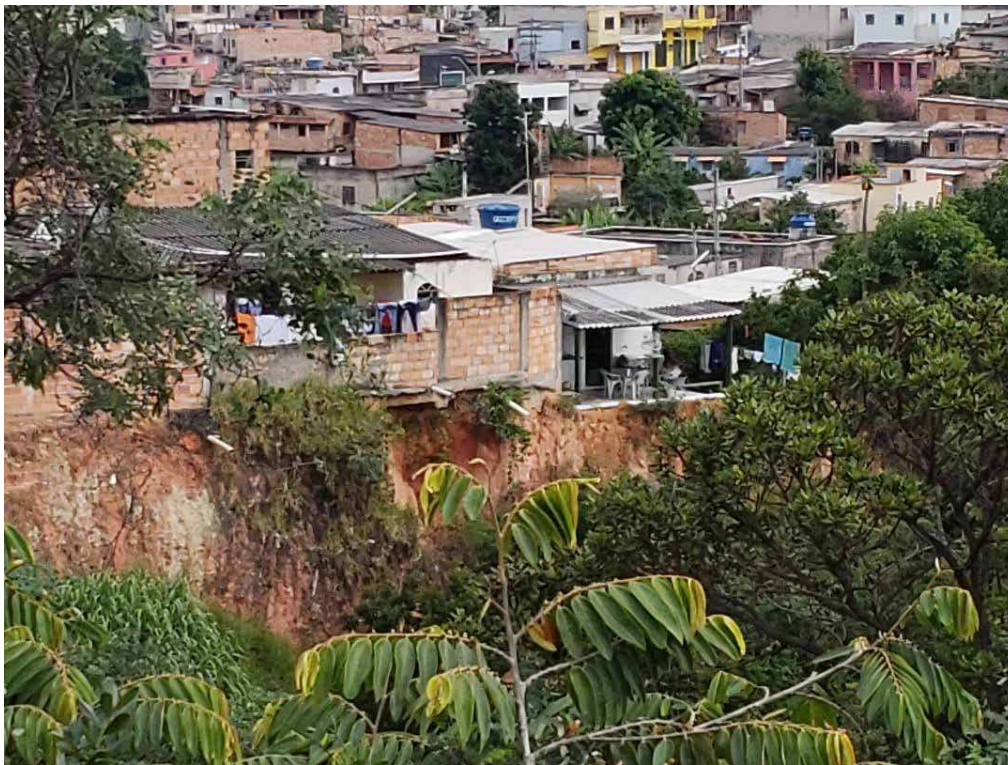
Figura 3 Vista da área ocupada da voçoroca e moradias construídas na crista, Vila Barroquinha, Contagem, MG.
