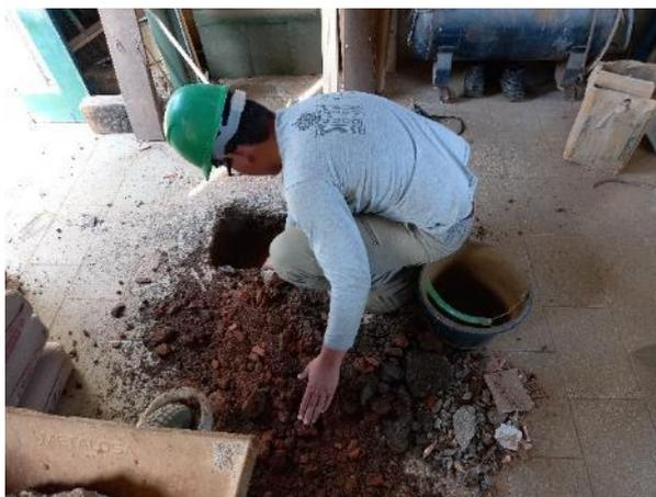
Figura 129 - Escavação e verificação da terra.
