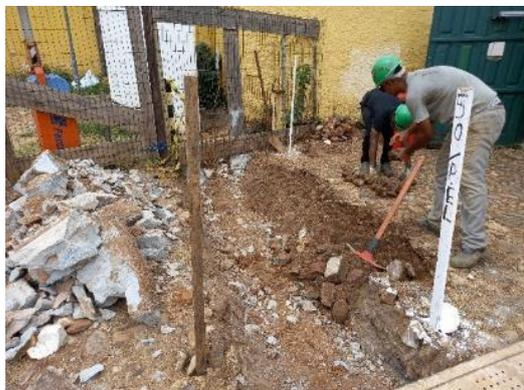
Figura 89 - Retirada de canaleta em concreto, início da trincheira 5.
