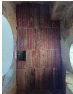
UNIFORMIZAR A TONALIDADE E APLICAR CAMADA DE PROTEÇÃO NO FORRO NOVO
