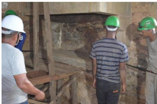
Figura 43 - Estrutura de madeira colocada ao lado do fogão para receber a laje.
