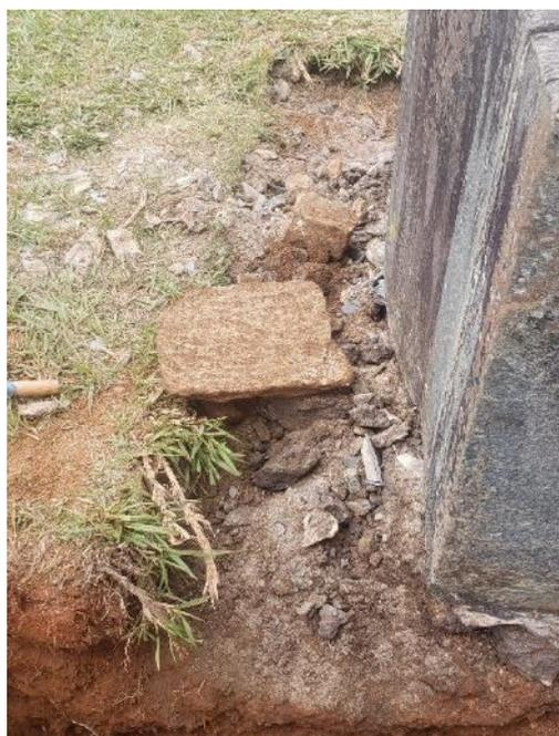
Figura 119 - Retirada do piso em volta ao chafariz.
