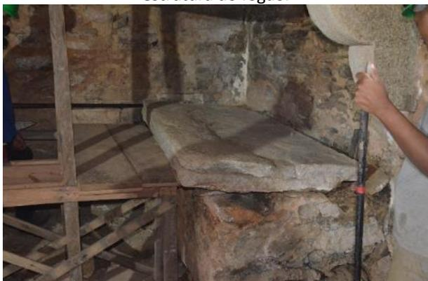
Figura 44 - Processo de remoção da laje.
