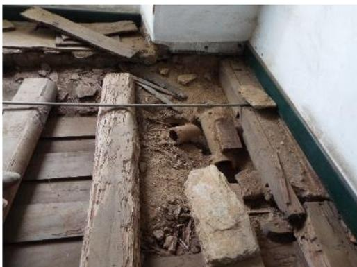
Figura 1 - Exemplo de vista do ponto em cima das paredes de pedra, onde os barrotes e o piso ficam apoiados.
