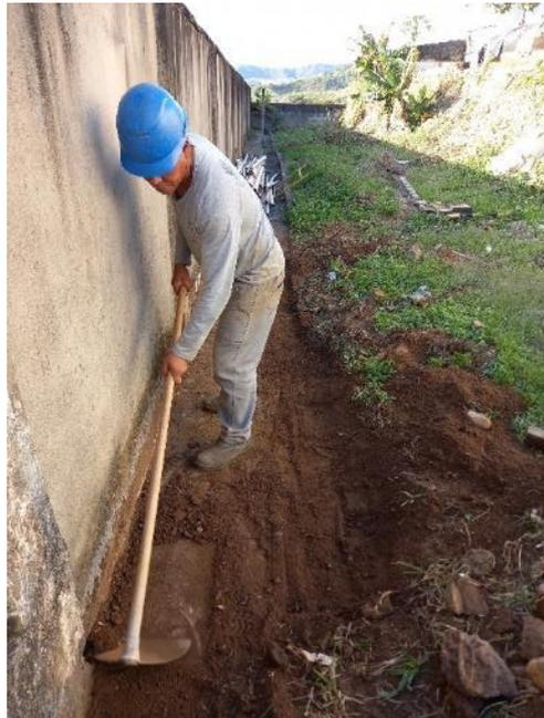
Figura 115 - Escavação da trincheira 15, junto à base do muro em área plana.
