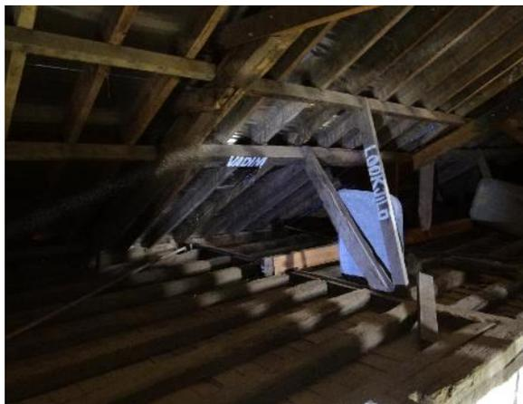
Figura 20 - Exemplo de inscrição feita com tinta branca na estrutura do telhado.
