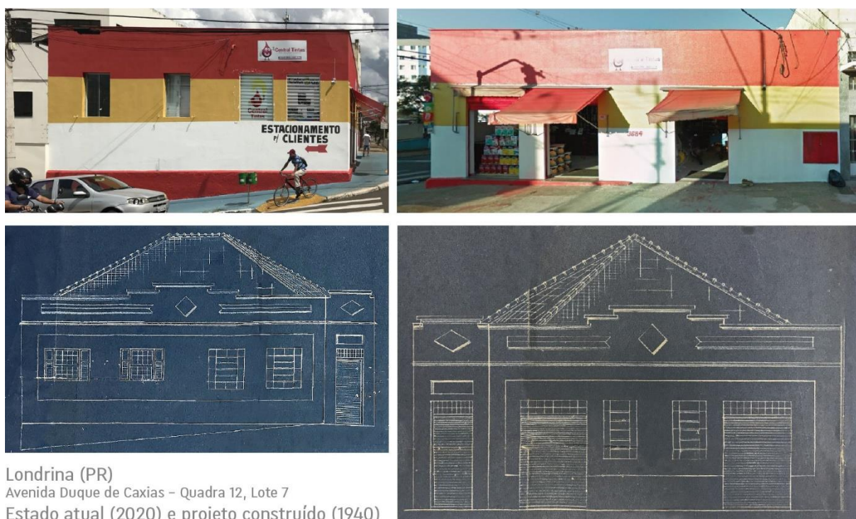
Figura 8. Fenômeno da descaracterização: remoção de ornamentos. Avenida Duque de Caxias, Londrina (PR)
