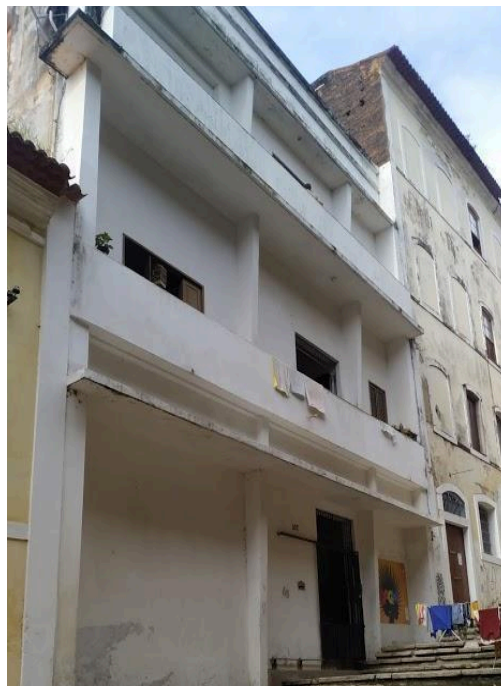
Figura 35 - Edifício Rua Humberto de Campos, nº 107.
