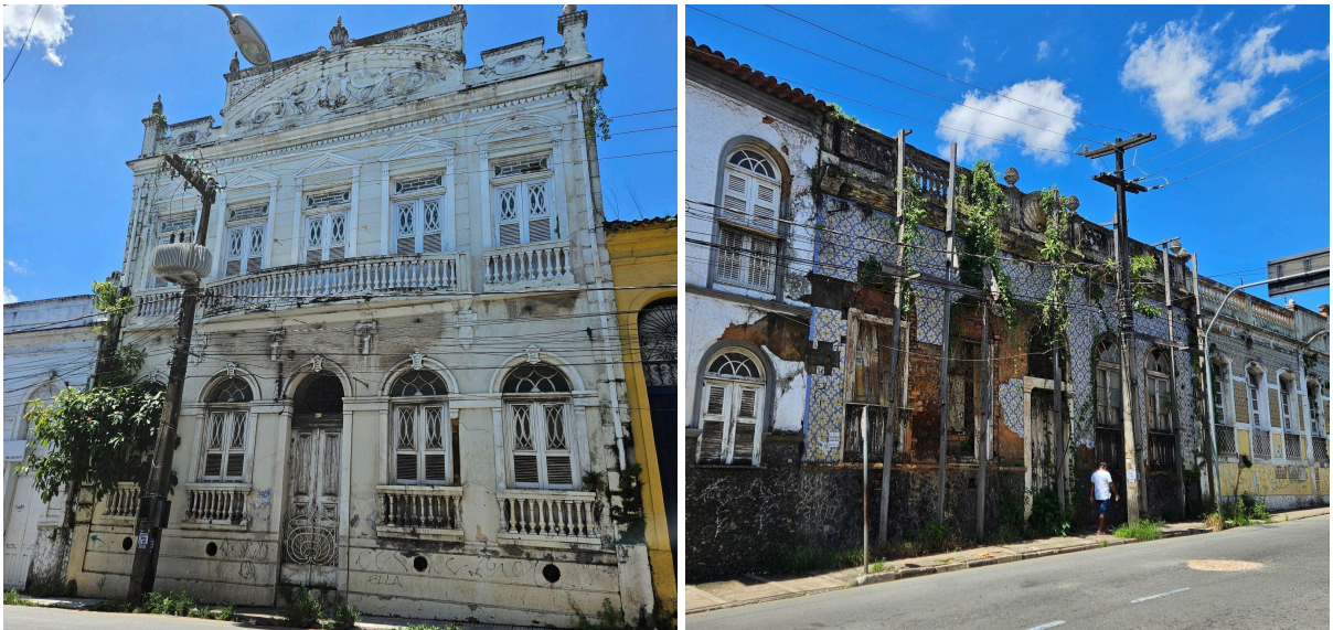
Figuras 65 e 66 - Edificações em péssimo estado de conservação na rua Rio Branco.
