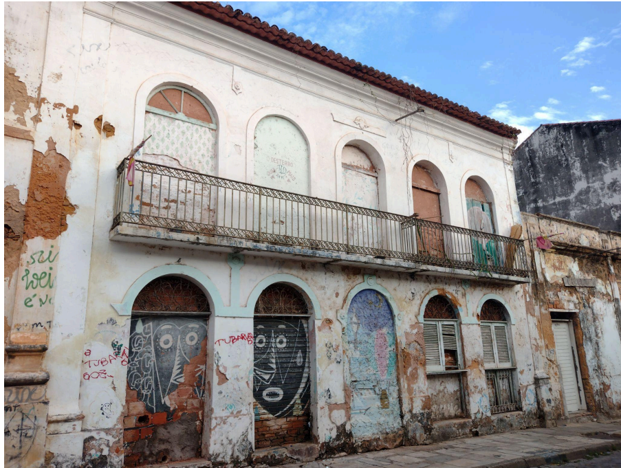
Figura 42 - Imóvel Rua da Palma, nº 445.
