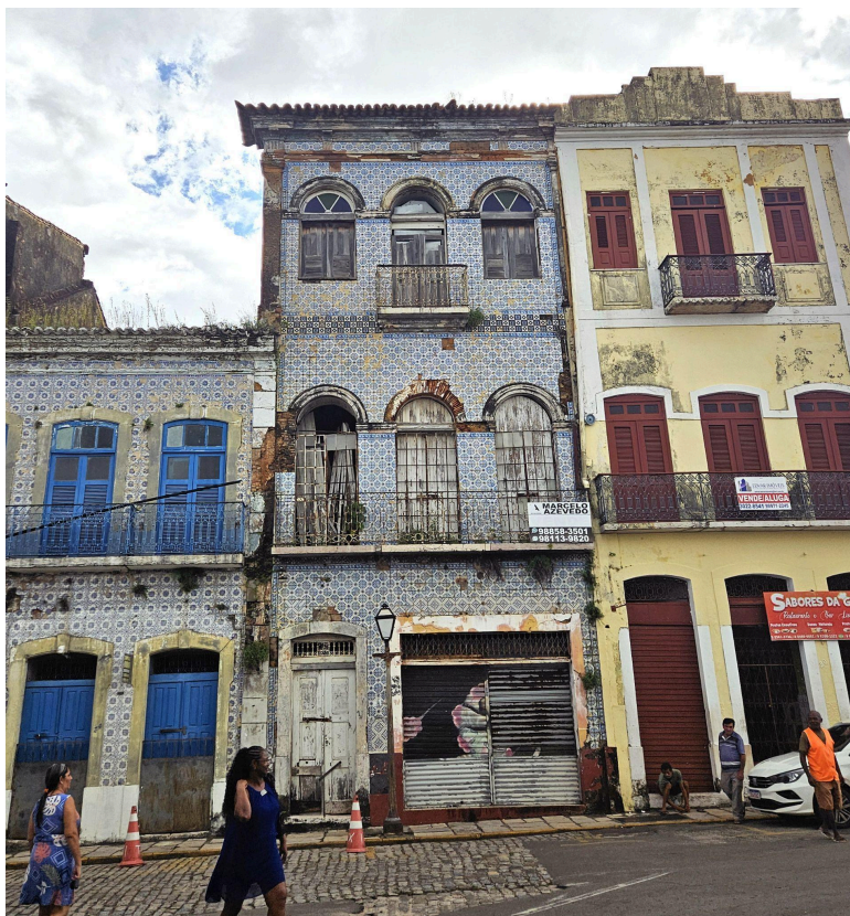
Figura 79 - Situação atual do antigo prédio do Reocupa.
