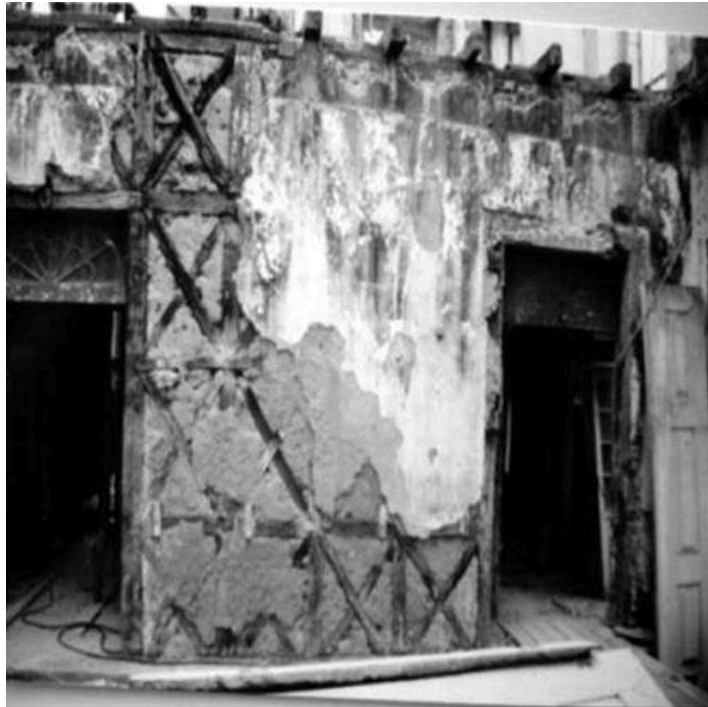
Figura 5 – Parede estrutural em cruz de Santo André, tipo gaiola pombalina.
