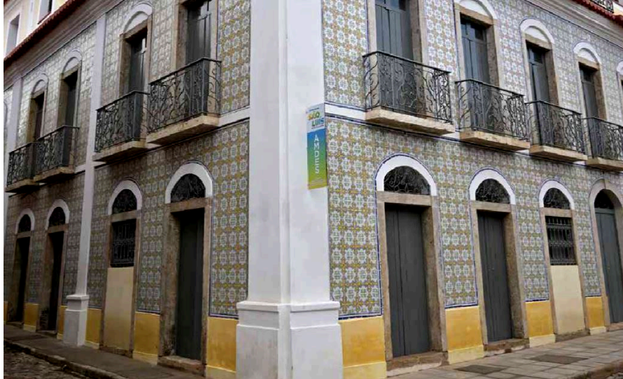
Figura 37 - Sobrado na Rua do Giz, nº 445.
