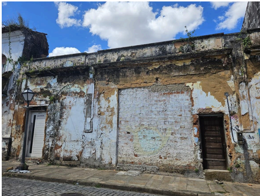
Figura 43 - Imóvel Rua da Palma, nº 459.
