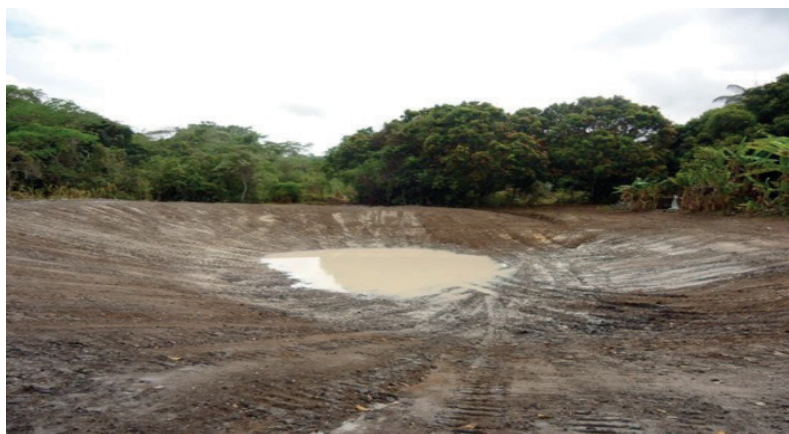
Figura 6. Barraginha construída na comunidade de Alto Lourenço – Turmalina.
