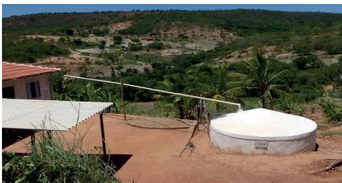
Figura 2. Cisterna de Placa.
