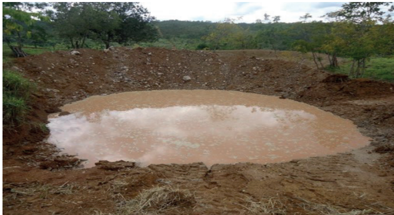
Figura 5. Bacia de Contenção construída na comunidade de Córrego dos Gomes - Turmalina.
