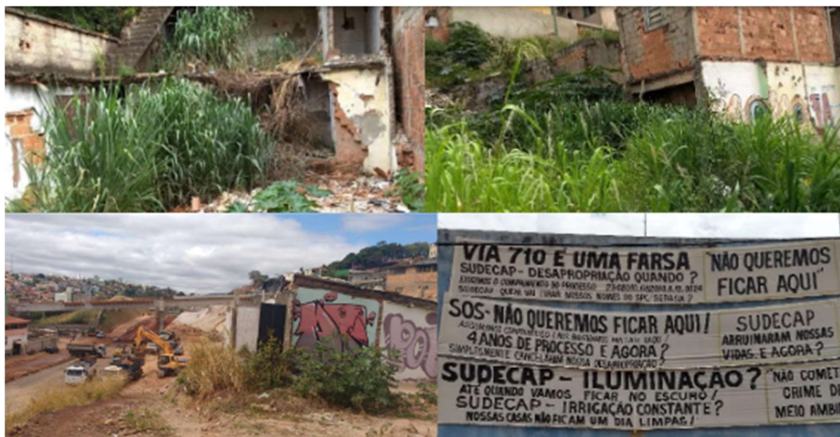
Figura 5 - Situação da Vila Arthur de Sá após início das remoções
