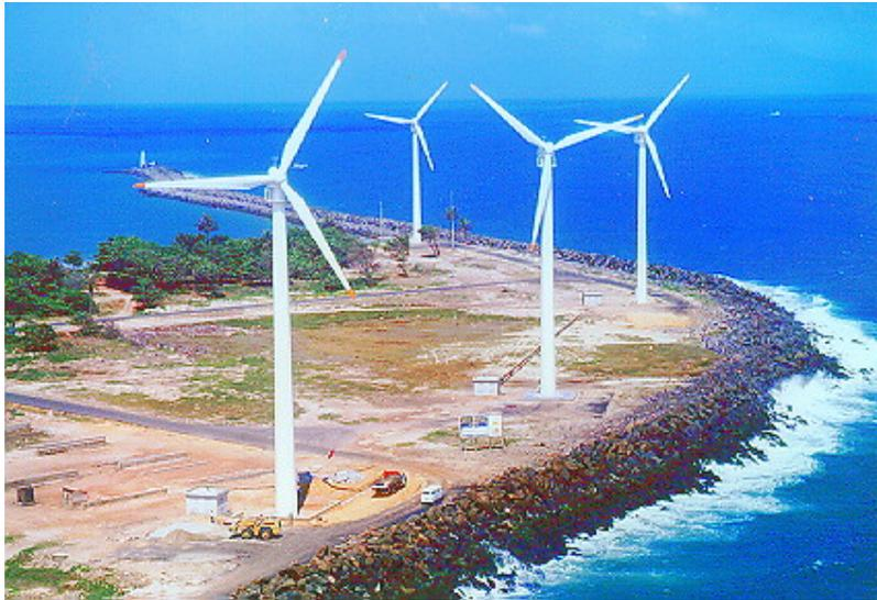
Figura 2 - Parque Eólico Modelo de 1,2 MW do Mucuripe, Fortaleza. A altura da torre é de 40 m e diâmetro das pás de 33 m. Fonte: <http://www.sfiec.org.br/artigos/energia>
