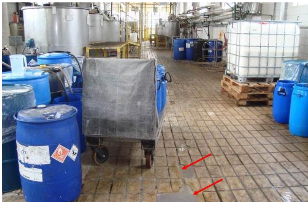
Figura 14- Vista geral da cozinha – trechos danificados no piso com peças faltantes.
