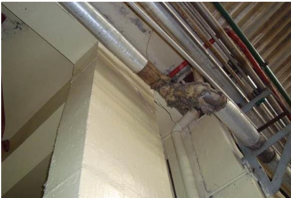
Figura 12- Vista de rachadura situada em topo de pilar.
