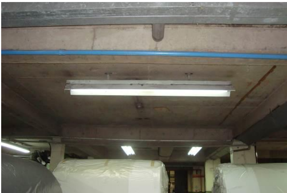
Figura 7- Vista da laje de cobertura do pavimento térreo.
