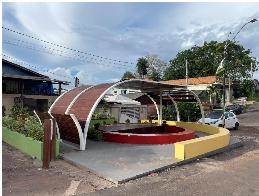
Figura 17 - Poço do Mato
