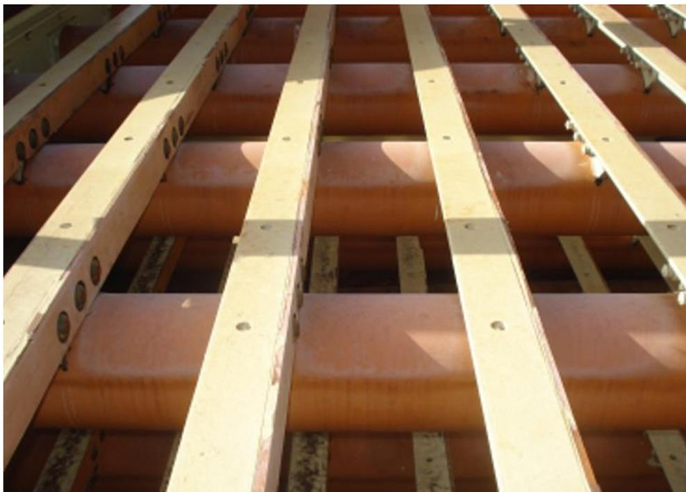
**FIGURA 3: Foto ilustrativa do aumento da espessura das longarinas.**
