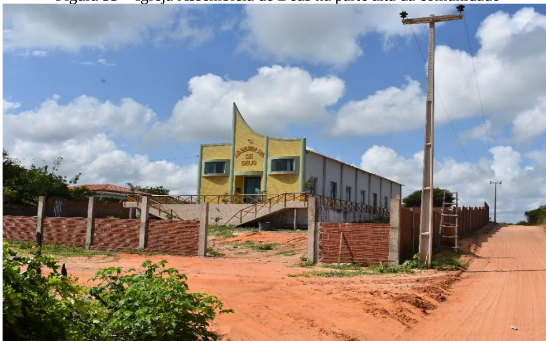
Figura 33 – Igreja Assembleia de Deus na parte alta da comunidade
