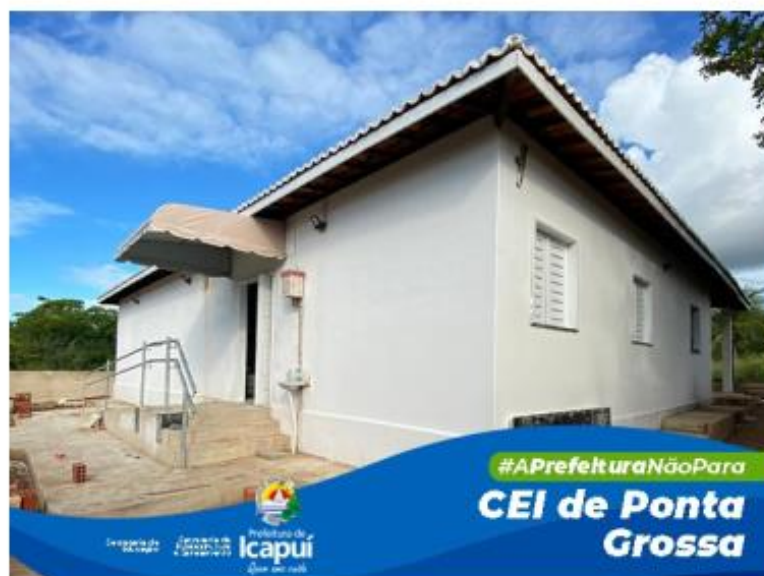
Centro de Educação Infantil em reforma - Foto: Anderson Pereira
