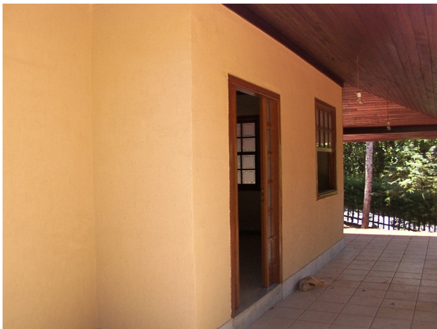
Figura 17 – Varanda: Paredes externas pintadas com tinta apropriada e esquadrias de madeira devidamente instaladas. Piso em cerâmica e forro de madeira.
