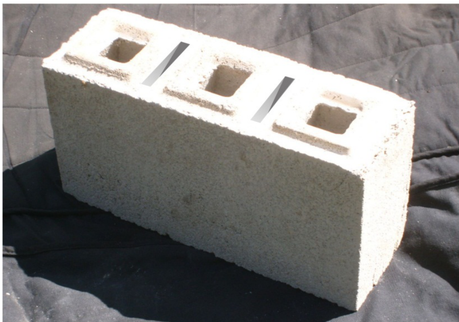
Figura 3 - Vista inferior do Bloco Somontar. Saliência superior caracterizando o encaixe do bloco e os vazios laterais para facilitar a separação dos módulos.
