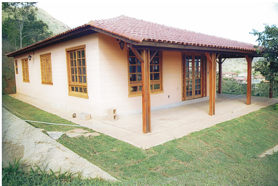
Figura 25 - Residência Unifamiliar/ Área: 138,89 m 2 - L 13, Q 05, Cond. Canto das Águas Rio Acima – MG.
