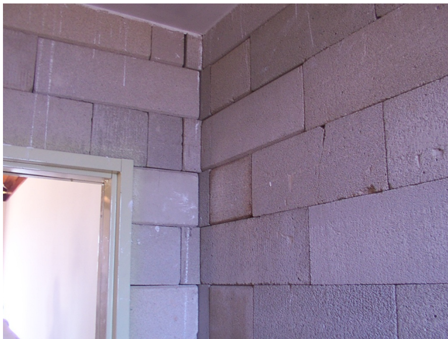
Figura 13 – Acabamento da espala da parede executada com Blocos Somontar e a esquadria instalada.
