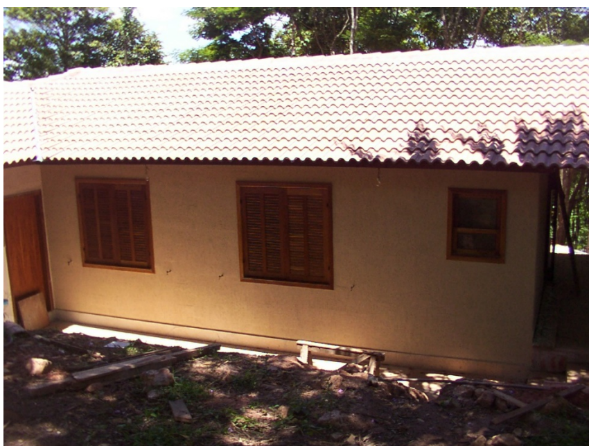
Figura 18 - Paredes externas pintadas com tinta apropriada e esquadrias de madeira devidamente instaladas. Piso em cerâmica e forro de madeira.
