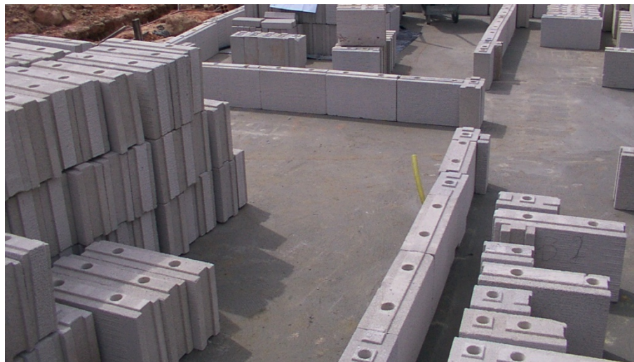
Figura 11– Blocos Somontar dispostos conforme locação das paredes.
