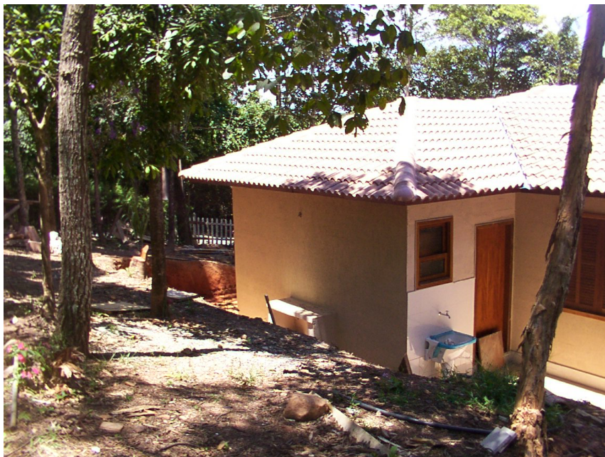
Figura 19 – Vista externa da residência já finalizada.
