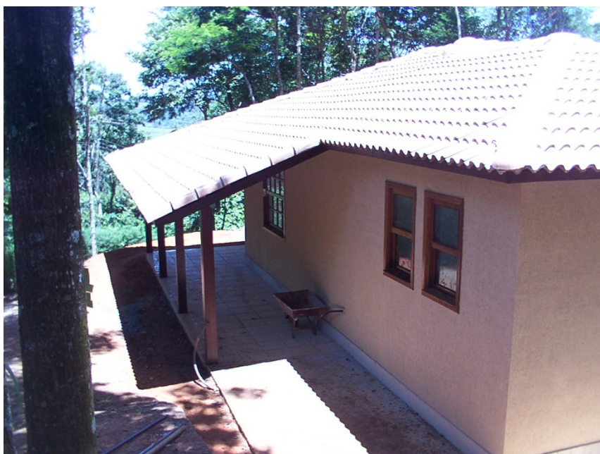
Figura 20 – Varanda lateral finalizada.
