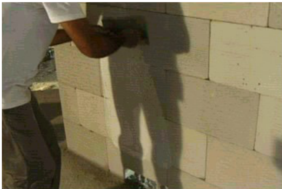
Figura 14– Aplicação de gesso liso sobre a parede que será pintada.
