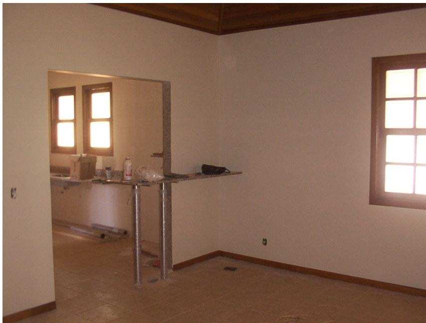
Figura 15 – Sala de Jantar e Cozinha acabadas. Piso, rodapés e esquadrias já instaladas.
