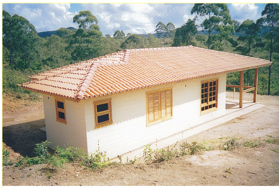
Figura 24 - Residência Unifamiliar/ Área: 96,23 m 2 - L 13 – Cond. Campo Grande de Vila Rica - Ouro Preto – MG.
