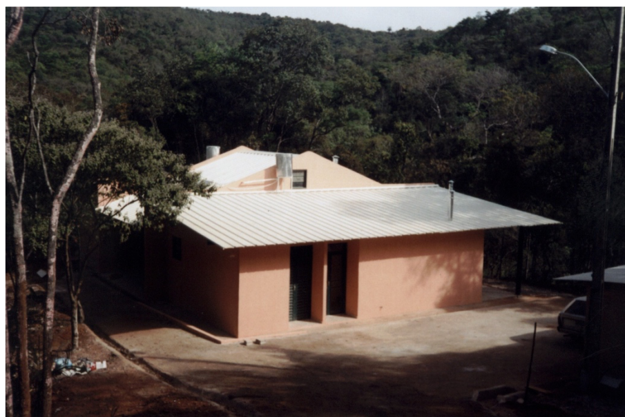
Figura 26 - Residência Unifamiliar/ Área: 236,88 m 2 - Rua 16, Jardins de Petrópolis – Nova Lima – MG.
