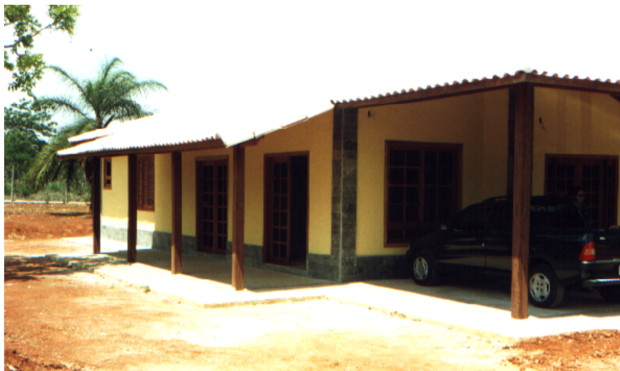
Figura 27 - Residência Unifamiliar/ Área: 136,21 m 2 - L22, Q07, Av. A, Cond. Condados de Bouganville, Lagoa Santa – MG.
