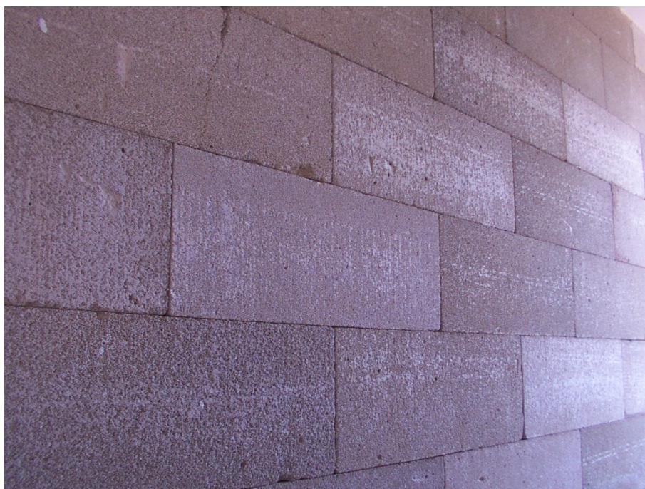
Figura 12 - Acabamento dos Blocos Somontar após a montagem da parede.
