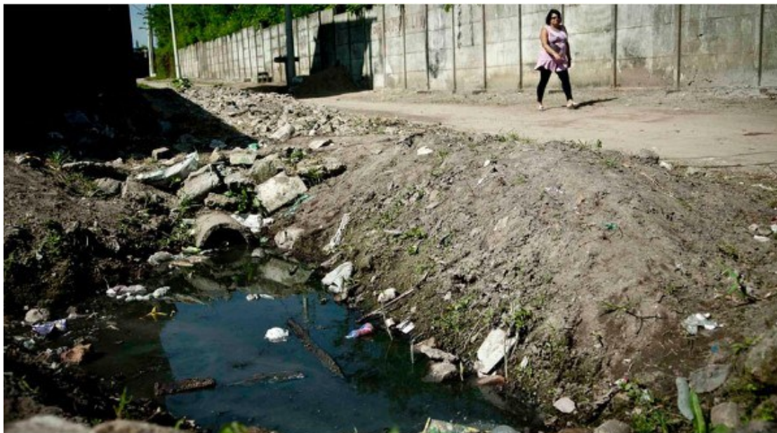
Figura 6. Lançamento de efluente em vala a céu aberto.
