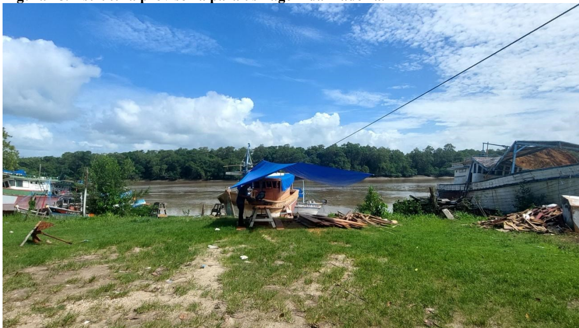
Figura 48. Estrutura provisória para usinagem da madeira.
