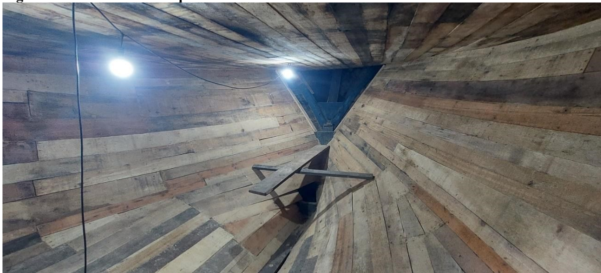
Figura 89. Revestimento do porão em madeira.
