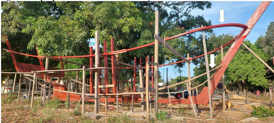
Figura 73. Ripas provisórias de forma e sustentação das cavernas.
