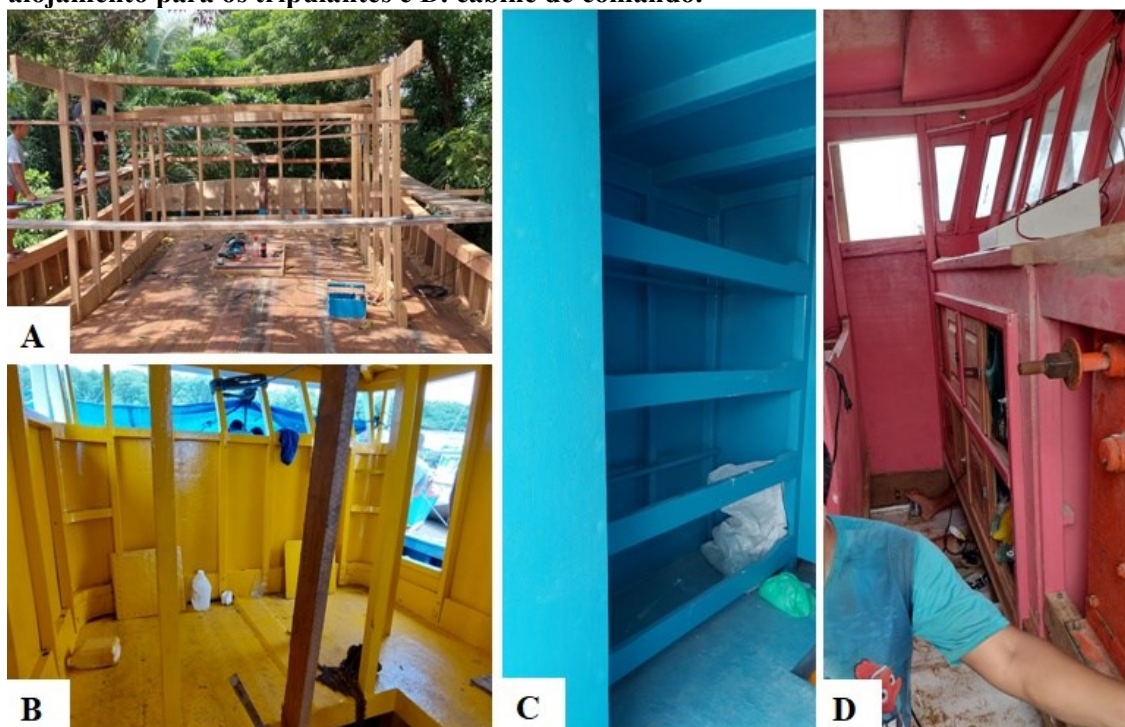
Figura 86. A. Estrutura da casaria, B. parte interna da casaria revestida e pintada, C. alojamento para os tripulantes e D. cabine de comando.
