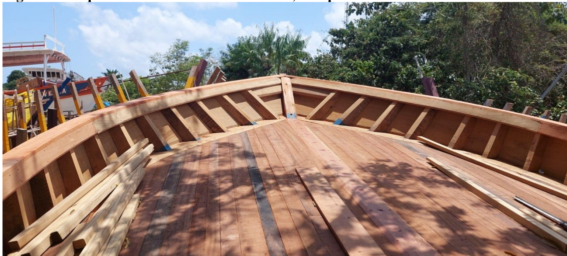
Figura 82. Aspecto final do convés de madeira, sem pintura.
