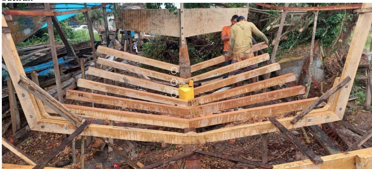
Figura 75. Instalação da parte inferior das cavernas, os círculos em branco indicam as bueiras.
