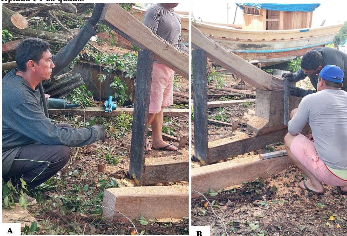
Figura 66. Processos de nivelamento das peças. A. esquadro de madeira para avaliar o ajuste entre as peças, B. usa-se o prumo para verificar o alinhamento entre o centro da espinha e o da quilha.
