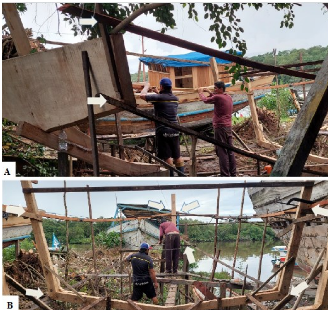
Figura 72. Na imagem A as setas indicam os suporte inferior e superior na popa da embarcação, na B as setas indicam o percurso dos suportes pelas cavernas de armação até o talha mar.
