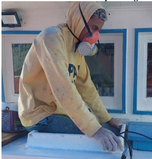
Figura 56. Fibrador reparando o interior de um tanque de água.
