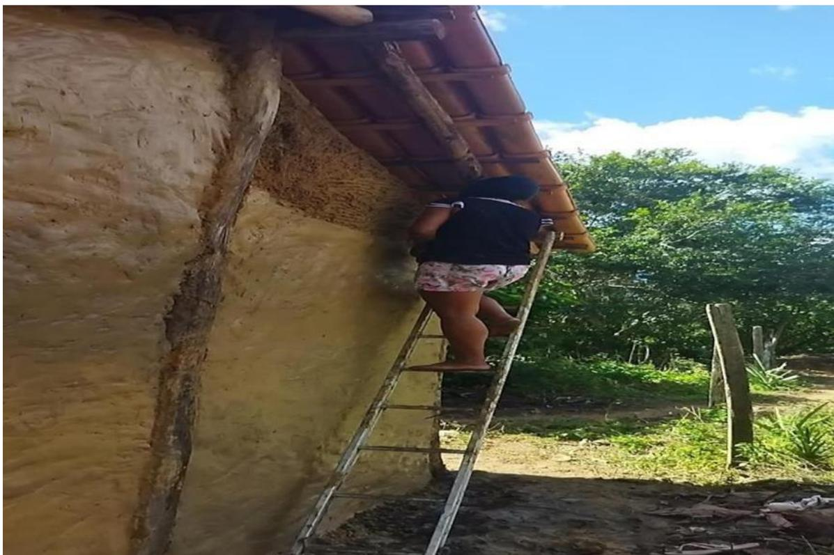
(Fonte: Naktã Pataxó, 2023, paredes sendo alisadas)
