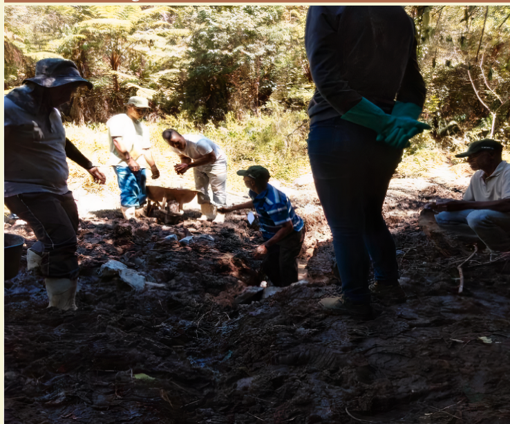
Figura 11: Fechamento da Nascente
