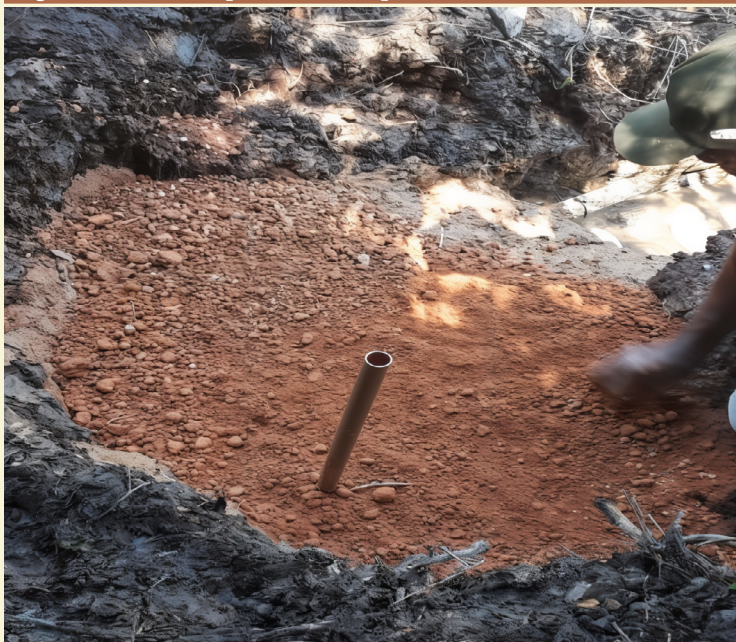
Figura 14: Tubulação para viabilizar o processo de sanitização da nascente.
