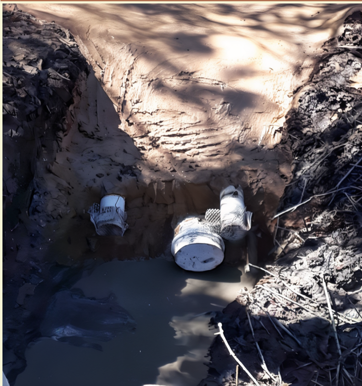
Figura 13: Visão da tubulação montada para viabilizar o processo de limpeza e esgotamento da água, ladrão para escoamento quando a vazão estiver muito grande e saída da água para a captação e abastecimento das casas. Procedimento de Caxambu (nome dado ao processo de recuperação de nascentes) finalizado
