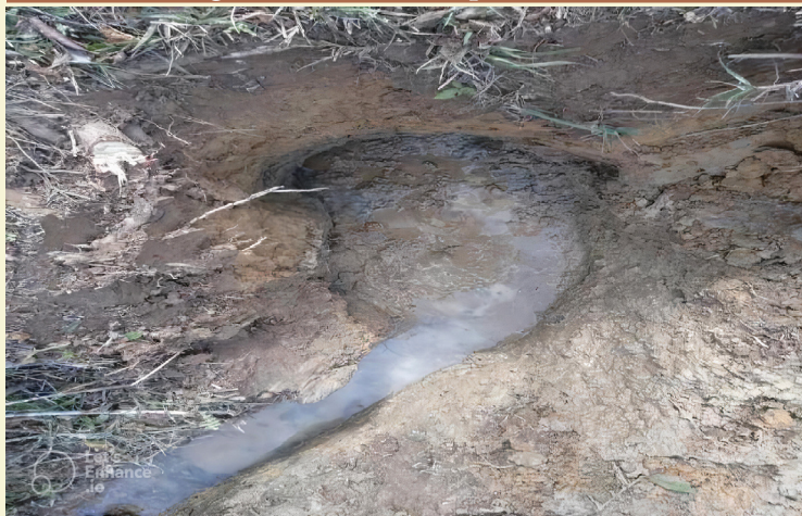
Figura 6: Nascente limpa e drenada
