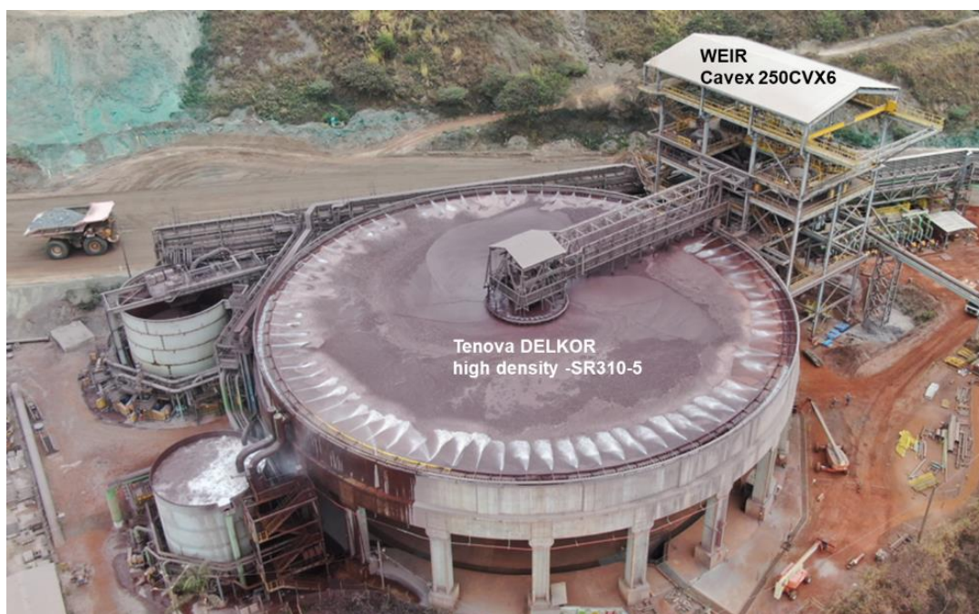
Figura 4: Espessador Tenova Delkor e prédio da Ciclonação.
