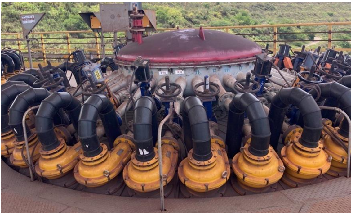
Figura 11: Ciclone WEIR CAVEX 250CVX6 presente na planta de Filtragem de Rejeito.
