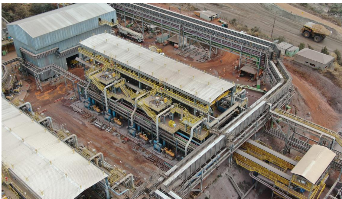
Figura 5: Prédio da filtragem de rejeitos.
