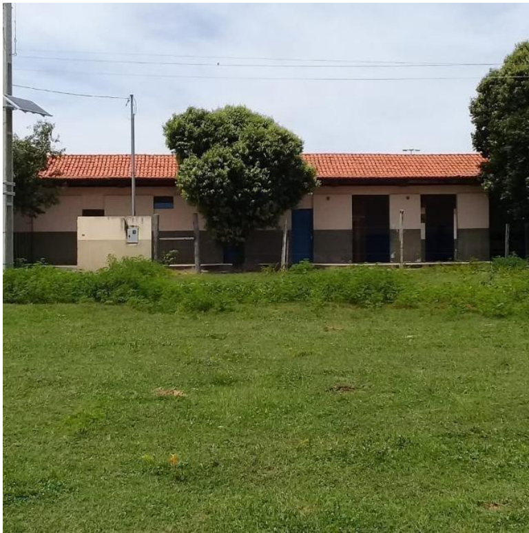
Foto 1: Vista parcial da Escola Municipal Santa Marta. Foto do autor.
