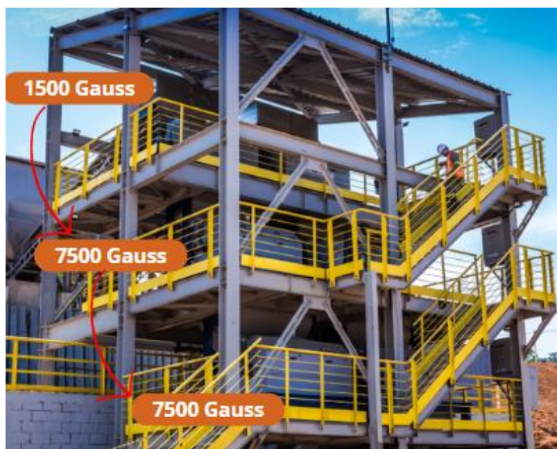
Figura 21- Foto do prédio de concentração magnética instalada
