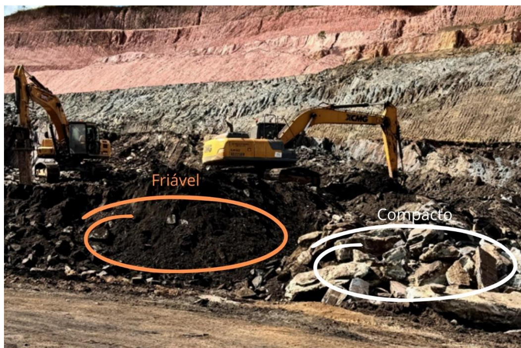
Figura 28 - Frente de lavra com material friável e compacto
