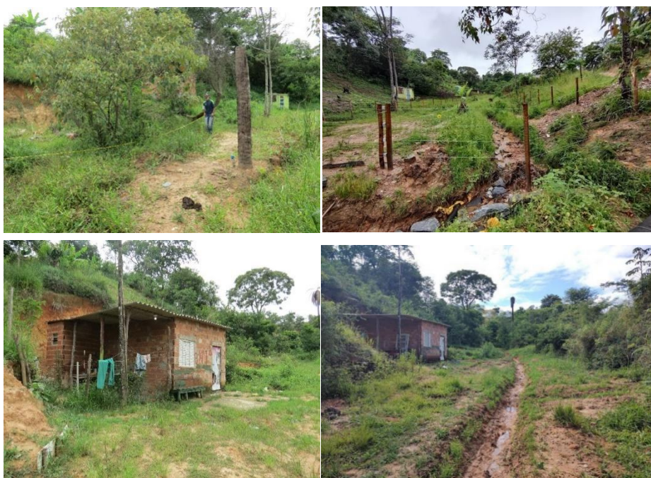
Figura 49 - Antes e depois da execução do dreno da Nascente 1
