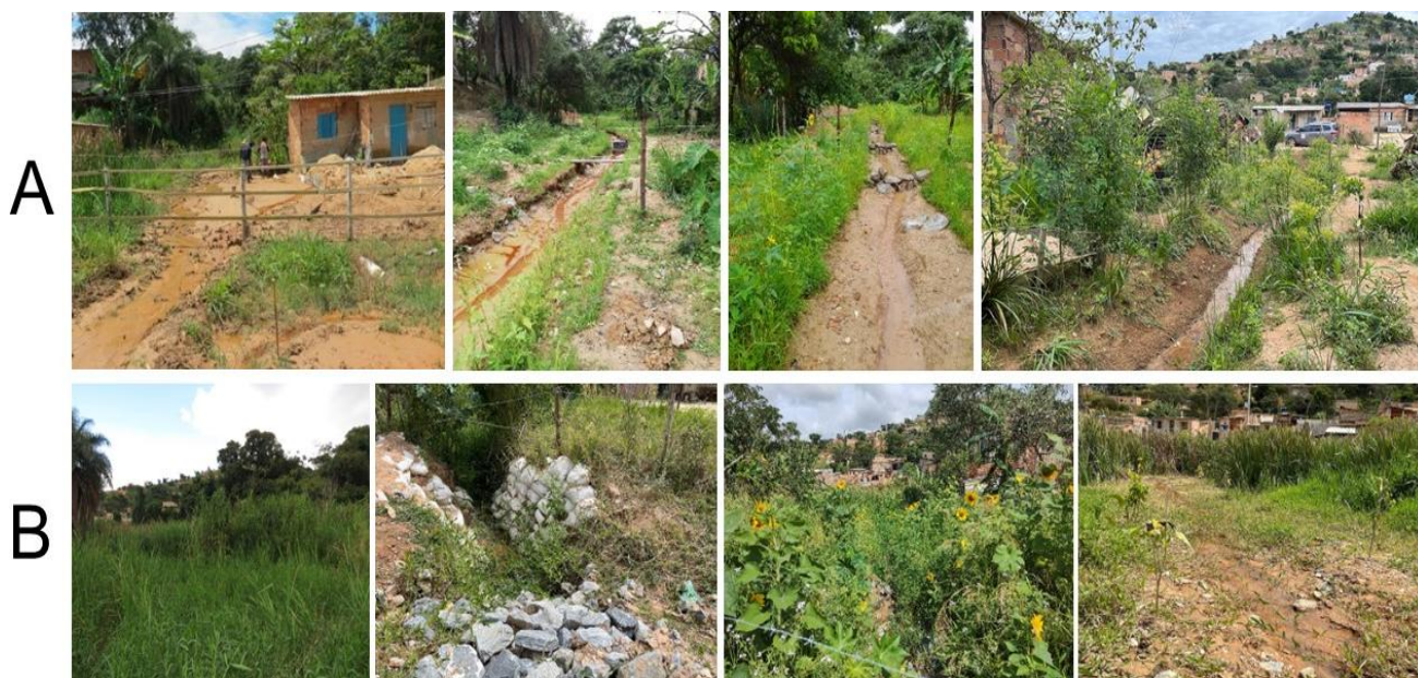
Figura 52 - Antes e depois da execução do dreno da Nascente 3A
