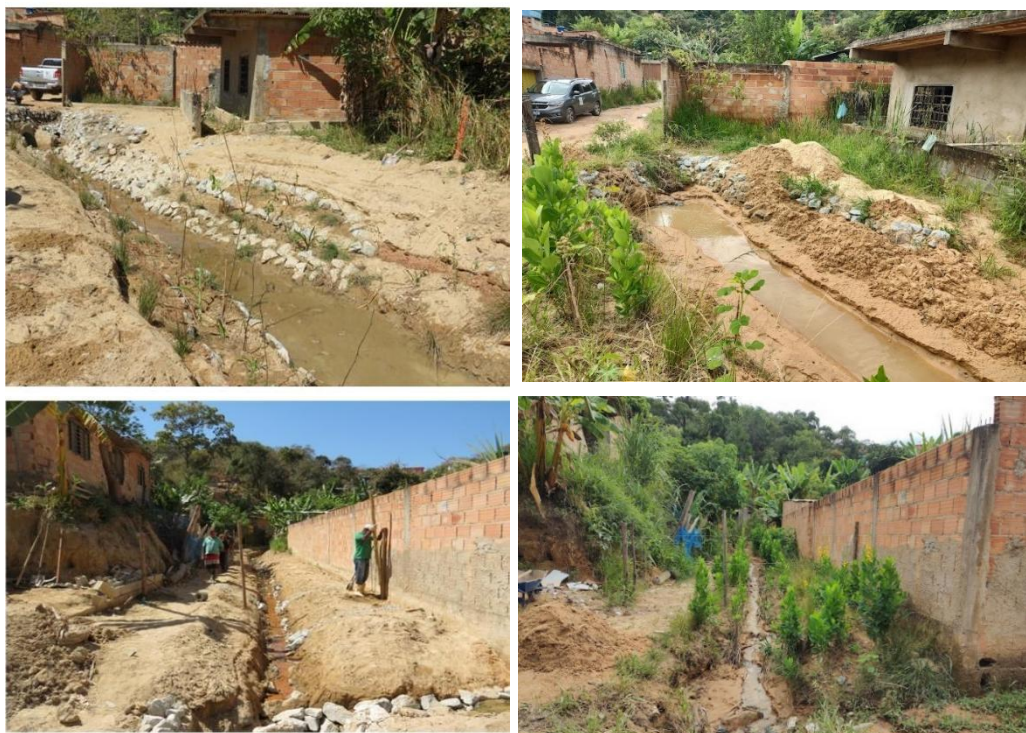
Figura 59 - Drenos no período da seca e no período chuvoso
