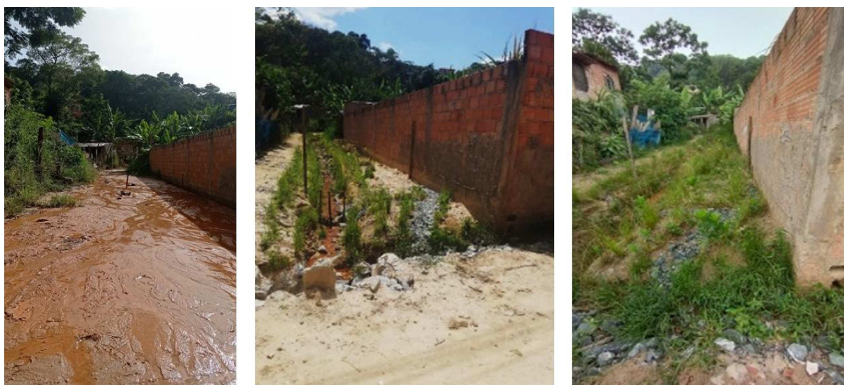
Figura 56 - Antes e depois da execução do dreno da Nascente 3B2
