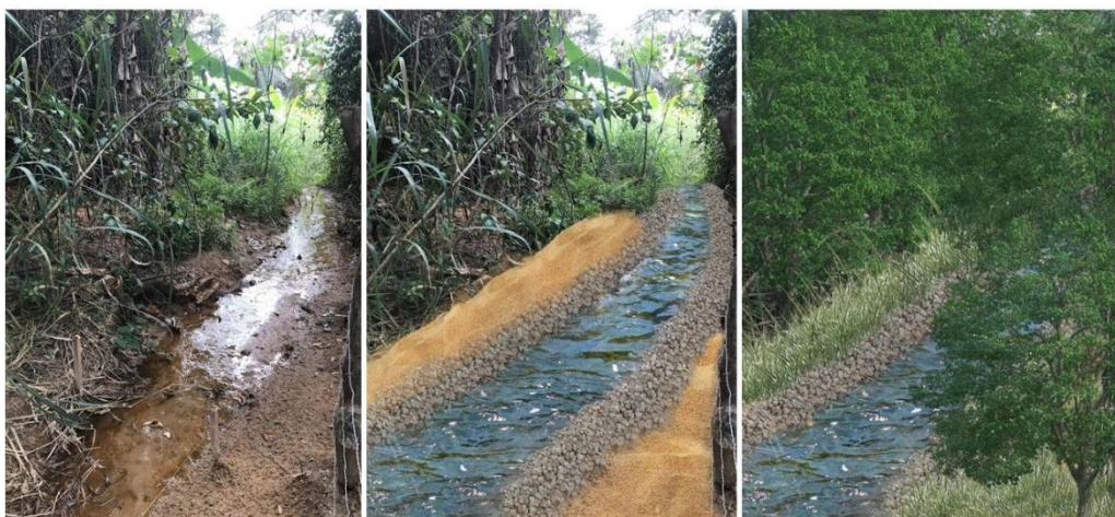
Figura 43 - Projeto antes e depois da abertura dos drenos
