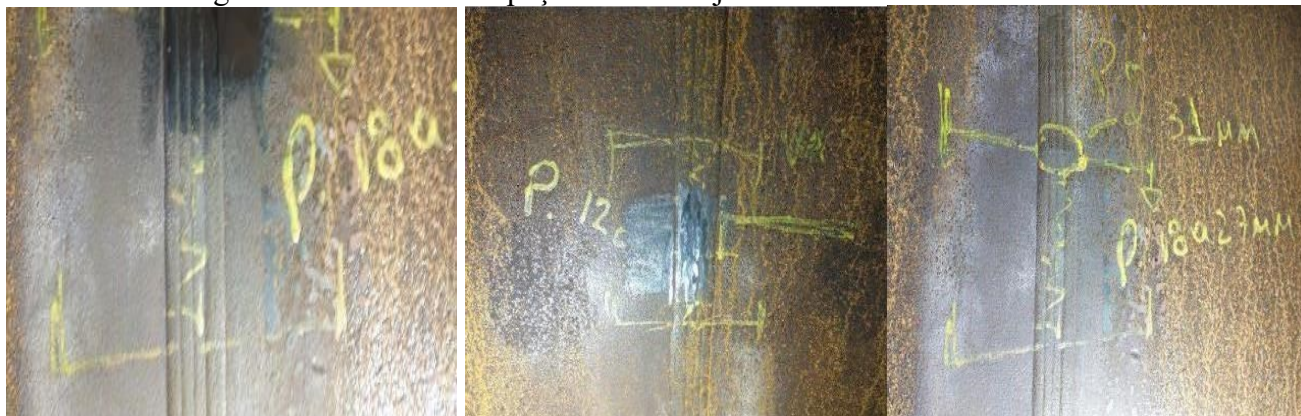
Figura 3: Processo de inspeção visual na junta soldada.
