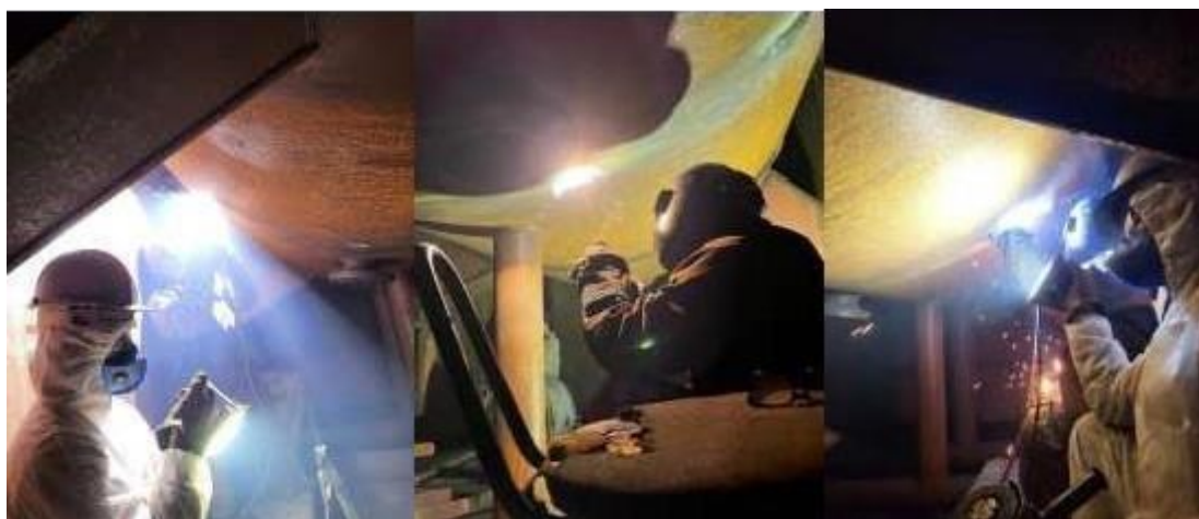
Figura 6: Processo de soldagem SMAW em ação
