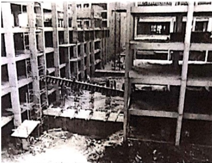
Imagem 33 – Fotografia da construção da UERJ
