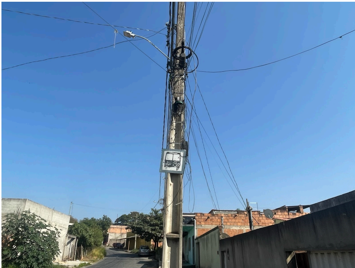
Figura 3. Ponto de ônibus, ao lado do Bar do Neguinho, na Rua Ceará, no Bairro Petrópolis em Santa Luzia
