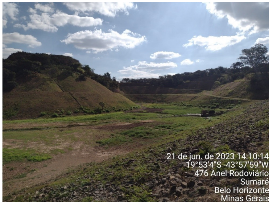
Figura 18 - Bacia de Contenção de Águas Pluviais
