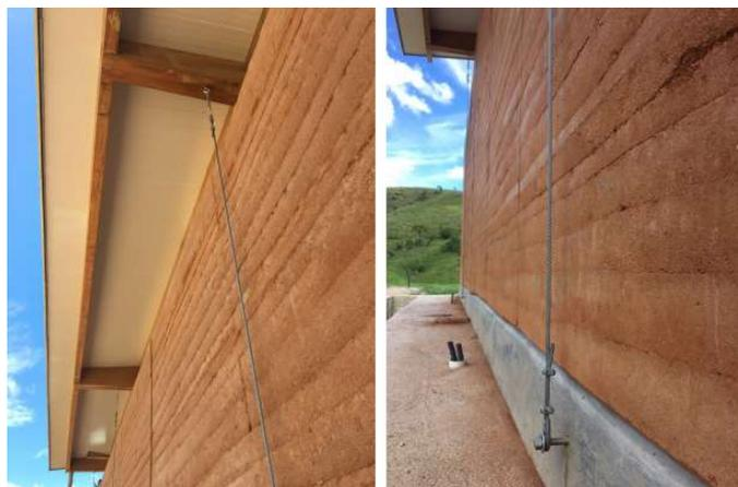
**Fig. 8** – Detalhe construtivo da ancoragem independente da taipa de pilão.
