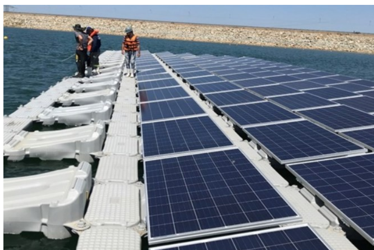
Figura 30. Usina flutuante com Hydrelío® sendo instalada na UHE de Sobradinho (CHESF).
