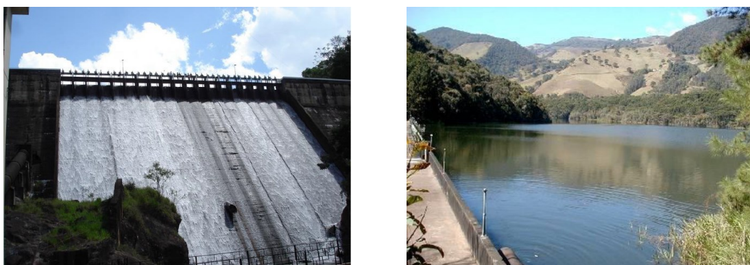
Figura 19. Barragem auxiliar (esquerda) e reservatório auxiliar (direita) da PCH REPI
