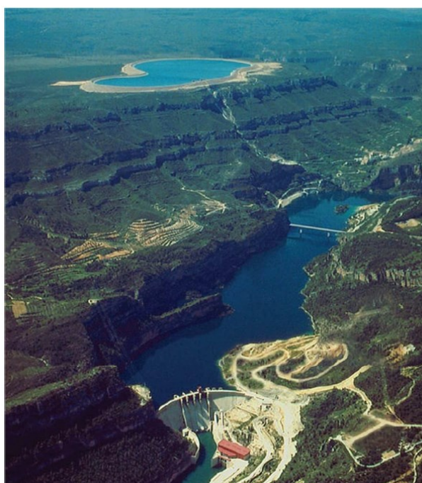
Figura 15. Vista aérea da UHR La Muela de Cortes
