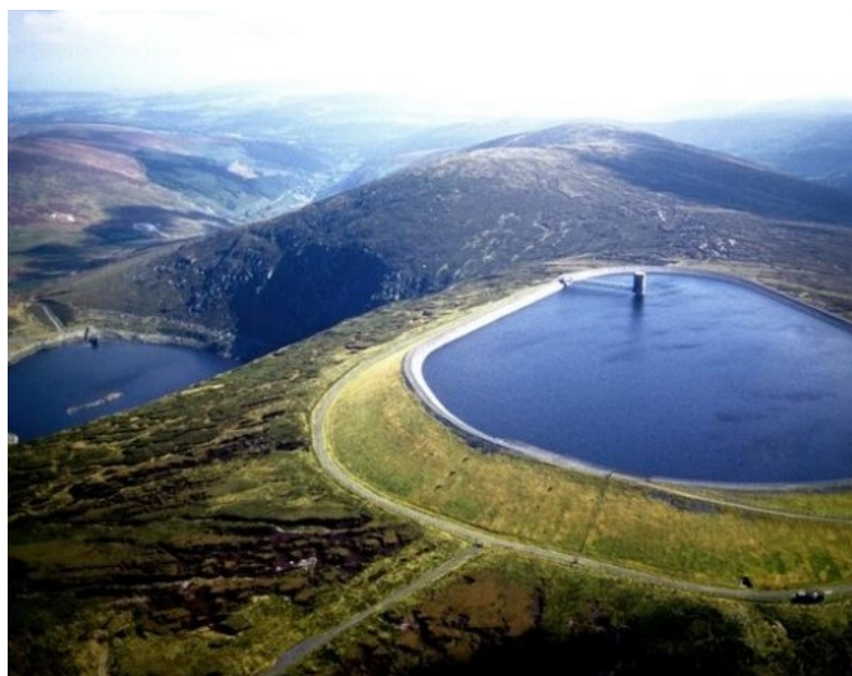
Figura 18. UHR de Turlough Hill – Exemplo de circuito fechado
