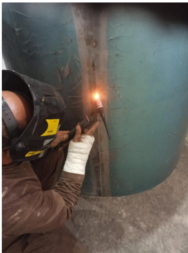
Figura 7 - Soldagem de topo das laterais do tanque realizada na posição ascendente.
